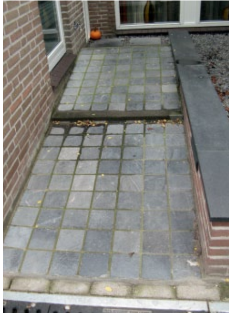
Figuur 2.6 Creatieve oplossing bewoners: oplopende stoep richting voordeur, met trede naar beneden voor de voordeur (particuliere dijk).
