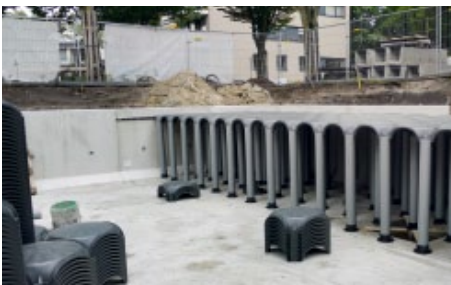
Figuur 2.10 Aanleg bergingskelders (Waterblock).
