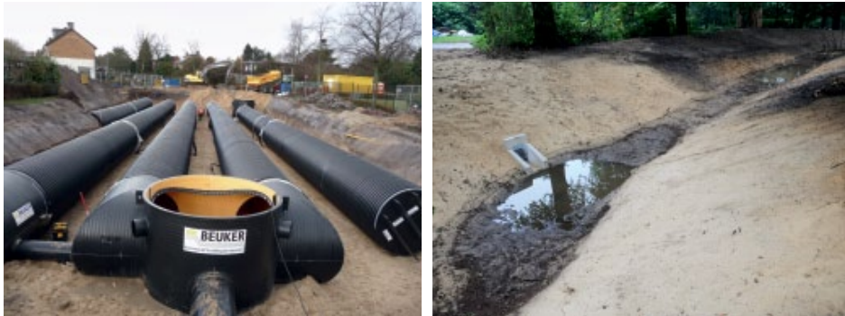
Figuur 7.3 Aanleg PE-infiltratiebuizen \varnothing 1.800 mm (links) en infiltratievijver (rechts).
