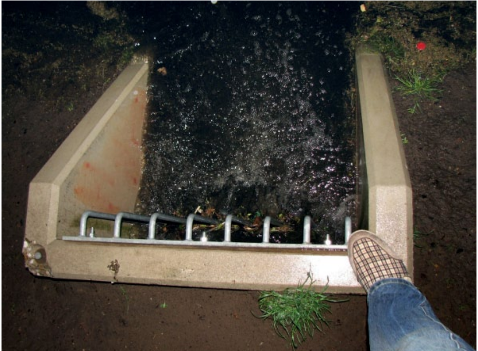
Figuur 6.7 Rooster bij uitstroomconstructie is lastig te reinigen.
