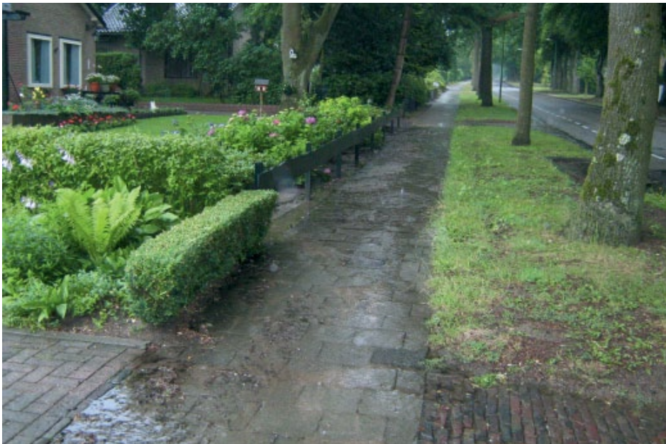
Figuur 7.11 Waterstroom verplaatst zich vanuit goot naar trottoir.
