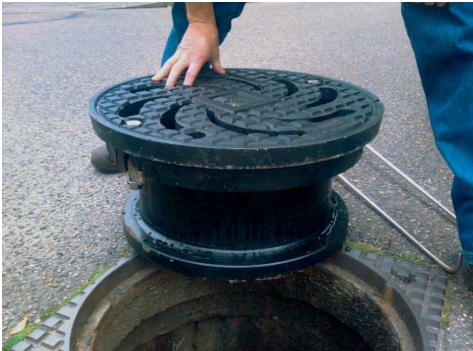
Figuur 17.20 Plaatsing van een ontluuchtingsputdeksel (Bron: TBS)
