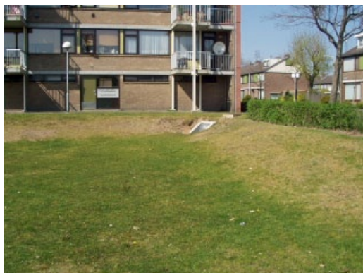
Figuur 6.8 Uitstroom bij flatgebouw.
