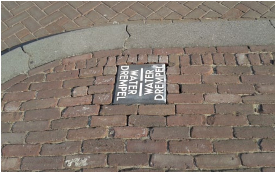
Figuur 13.3 'Watertegel' in Egmond aan Zee geeft aan dat de straat als waterdrempeel fungeert.
