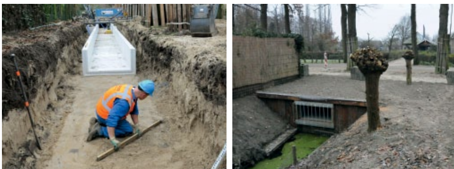
Figuur 7.4 Aanleg goot onder het trottoir (links) en instroom goot vanuit vijvers boven reguliere duiker (rechts).
