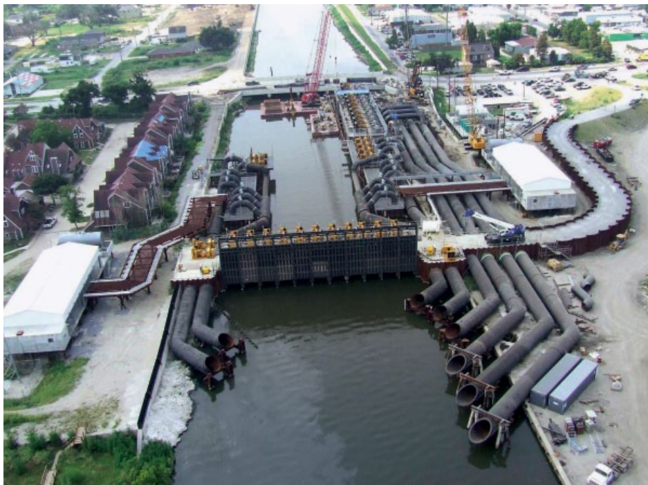
Figuur 12.5 Afsluiter en pompstation (interim) 17th Street uitlaatkanaal, bron: US Army Corps of Engineers, 2008.
