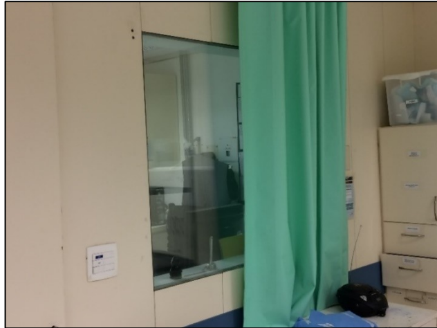
Figura 8: Vidro Plumbífero separando a sala de comando da sala cirúrgica.
