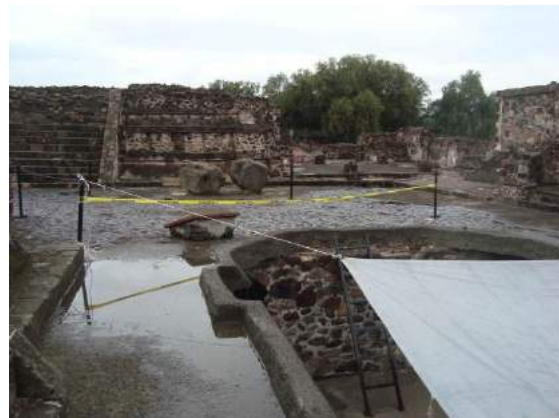
Fig. 5.50 Encharcamiento sobre la losa de concreto. Archivo DCR-ZMAT
