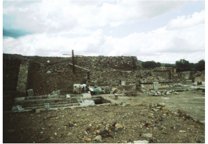
Fig. 3.32. Fachada este del basamento 40A, proceso de reconstrucción. Fototeca CET-ZMAT.
