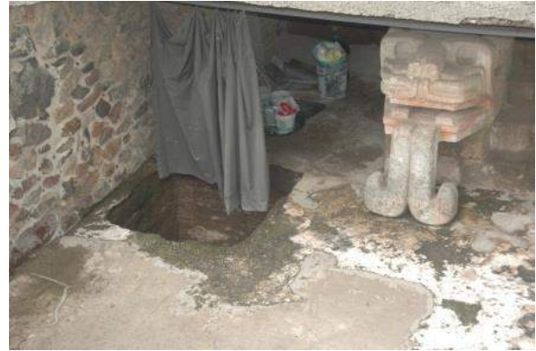
Fig. 5.44 Cortina en escalinata oeste que ha desprendido el estucado en la base de la lengua bífida de la escultura.
