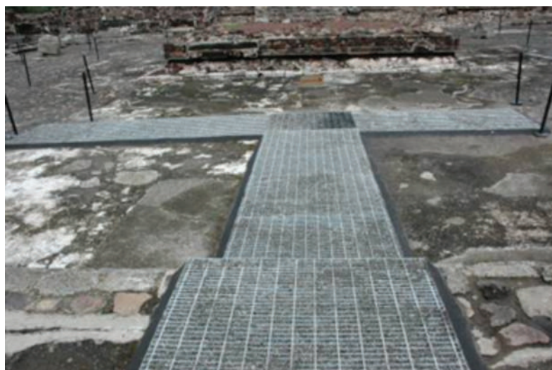
Fig. 3.44. Corredor de rejilla en el pasillo de acceso principal del Conjunto en 2007. Archivo Departamento de Conservación y Restauración ZMAT.
