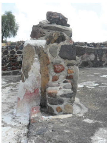
Fig. 2.10. Vista lateral de un muro en el conjunto.
