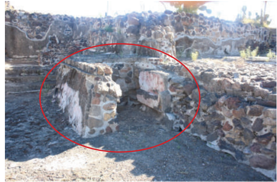
Fig. 3.7. Sobreposición de talud sobre tablero en Adoratorio 1.
