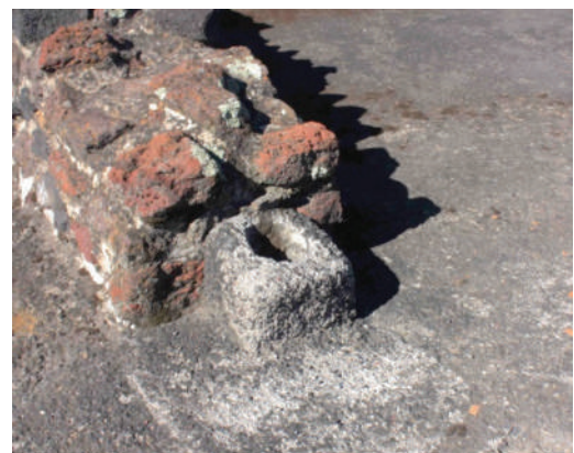
Fig. 2.16. Testigo de la existencia de morillo.
