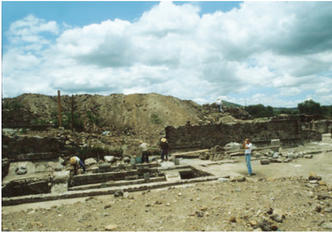
Fig. 3.31. Fachada este del basamento 40A, proceso de reconstrucción. Fototeca CET-ZMAT.
