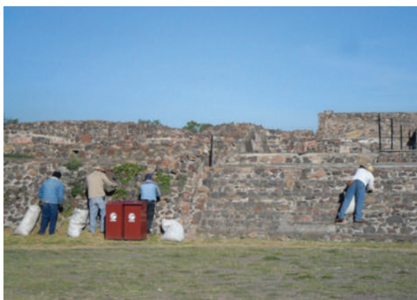
Fig. 6.34. Mantenimiento menor que se lleva frente a la plataforma del Conjunto Plaza Oeste. Liliana Alfaro.
