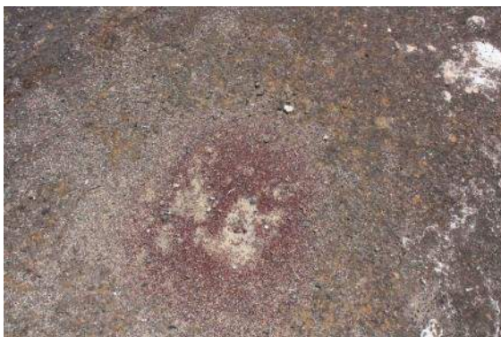
Fig. 5.58. Hormiguero en un piso de enlucido.
