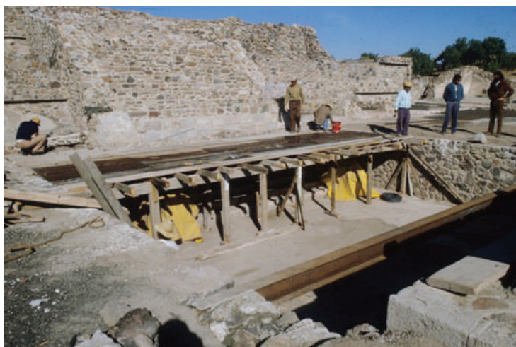
Fig. 3.41. Colado de concreto para cubrir la ventana arqueológica. Fototeca CET-ZMAT.
