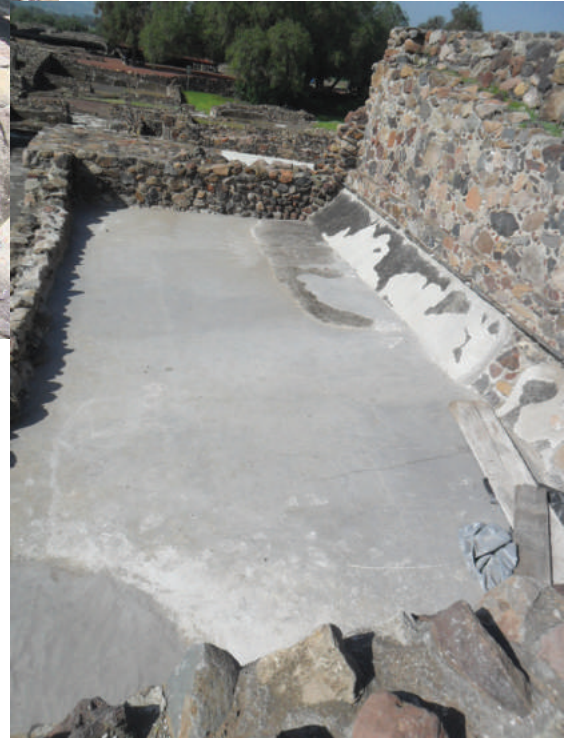
Fig. 3.54. Entrecalle del primer cuerpo sección sur, después de la restitución del firme de cal. Archivo DCR-ZMAT.
