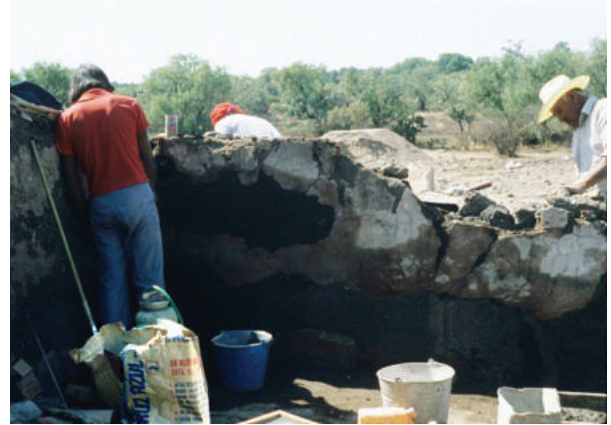
Fig. 3.28 Consolidación de muros con cemento, nótese el bulto de cemento. Fototeca CET-ZMAT.
