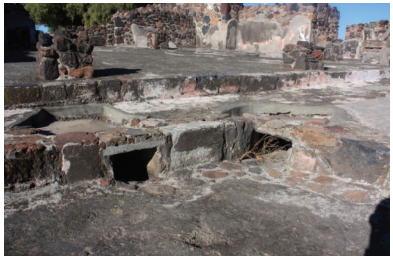
Fig. 2.24. Desagües en la plaza central.
