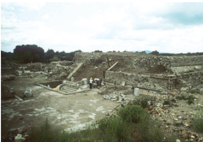
Fig. 3.35. Fachadas este y norte del basamento 40A, proceso de reconstrucción. Fototeca CET-ZMAT.
