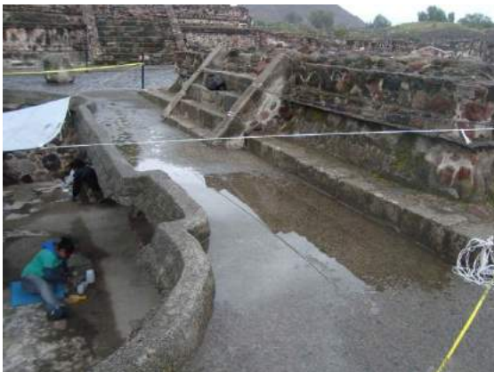
Fig. 5.49. Encharcamiento sobre la losa de concreto. Archivo DCR-ZMAT
