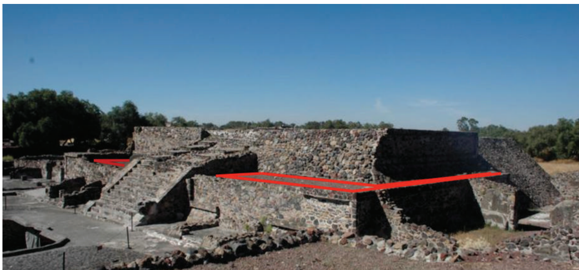
Fig. 3. 52. Basamento 40A que muestra los pisos de las entrecalles del primer cuerpo, mismos que hasta antes del 2012, carecían de firmes de piso.
