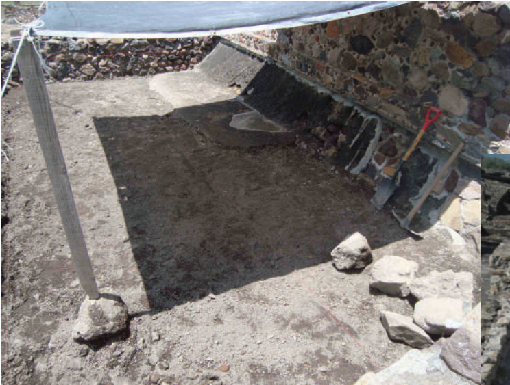
Fig. 3.53. Entrecalle del primer cuerpo sección sur, antes de la restitución del firme de cal. Archivo DCR-ZMAT.
