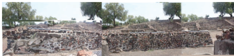
Fig. 6.19. Vista de sur a norte de la circulación abierta 12.
