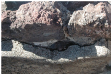
Fig. 5.1. y 5.2. Desprendimiento de aplanado al muro que permite el ingreso de humedad por filtración.
