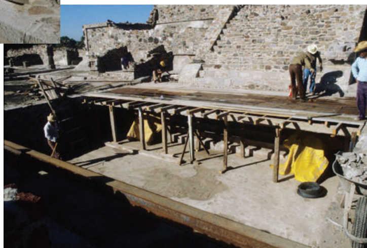
Fig. 3.42. Colado de concreto para cubrir la ventana arqueológica. Fototeca CET-ZMAT.
