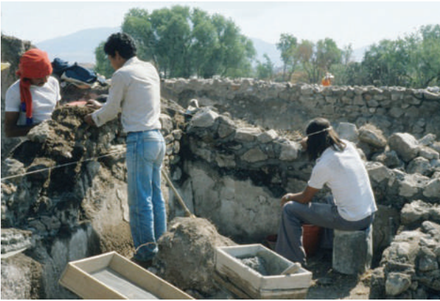
Fig. 3.27 Consolidación de muros con cemento. Fototeca CET-ZMAT.
