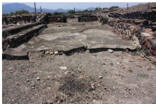
Fig. 2.30. Piso de aplanado, cuya pérdida parcial permite observar su fábrica.
