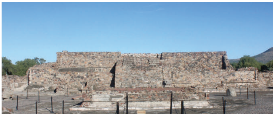
Fig. 2.6 Fachada Este con tableros en el primer cuerpo del basamento 40A.
