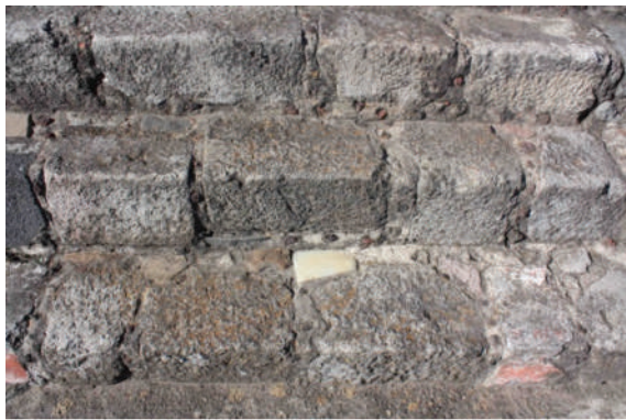
Fig. 2.19. Sillares de escalinata.
