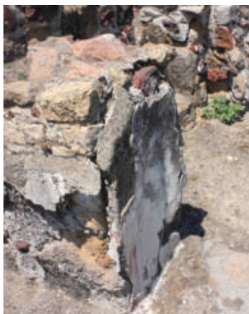
Fig. 5.1. y 5.2. Desprendimiento de aplanado al muro que permite el ingreso de humedad por filtración.
