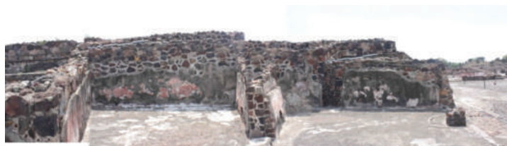
Fig. 6.17. Vista de oeste a este de la circulación cubierta 8.
