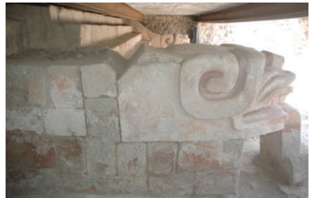
Fig. 5.23. Alfarda sur de la escalinata oeste de la ventana arqueológica que muestra concreciones salinas en los sillares.
