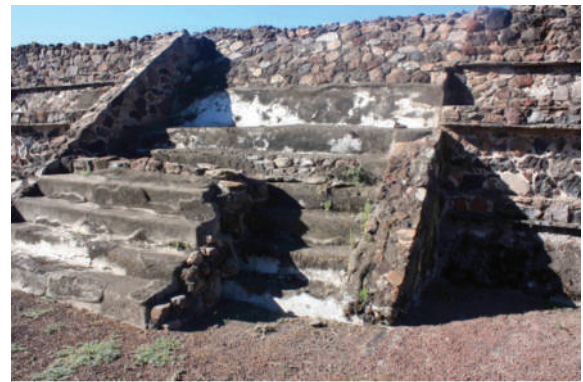
Fig. 2.20. Escalinata de mampostería recubierta de aplanado y enlucido.
