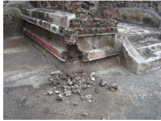
Fig. 5.54. Fractura de un ixtapaltete que causó el desprendimiento del tablero en un adoratorio.
