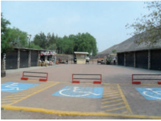
Fig. 5.92. Estacionamiento, locales de venta y módulo de revisión de ingreso a visitantes en puerta 5.
