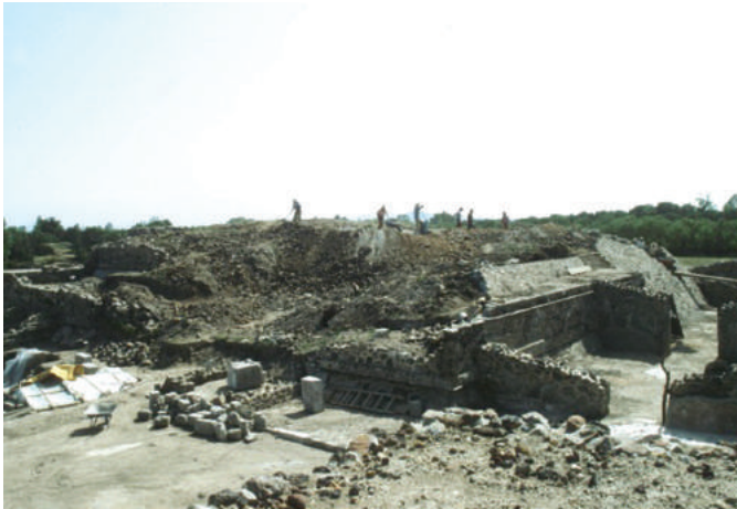
Fig. 3.33. Fachadas este y norte del basamento 40A, proceso de reconstrucción. Fototeca CET-ZMAT.
