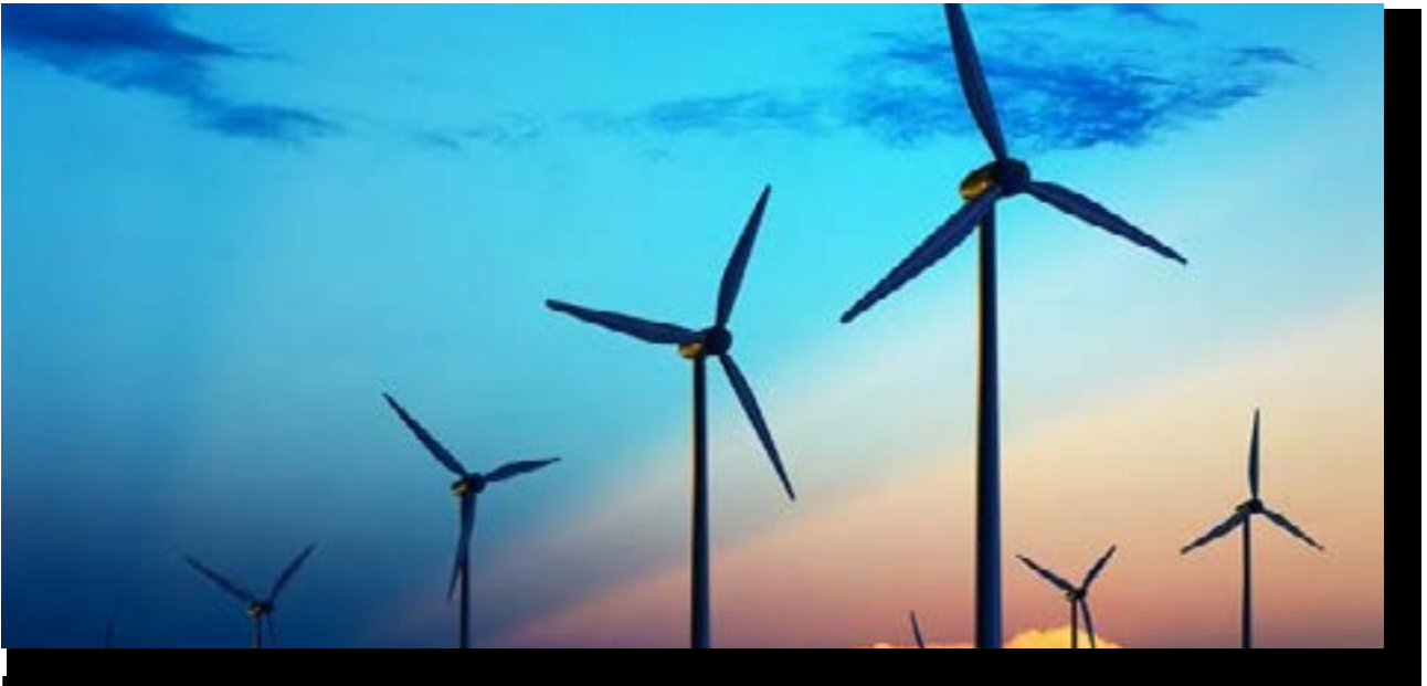
Figura 12. Parque de generación eólica
