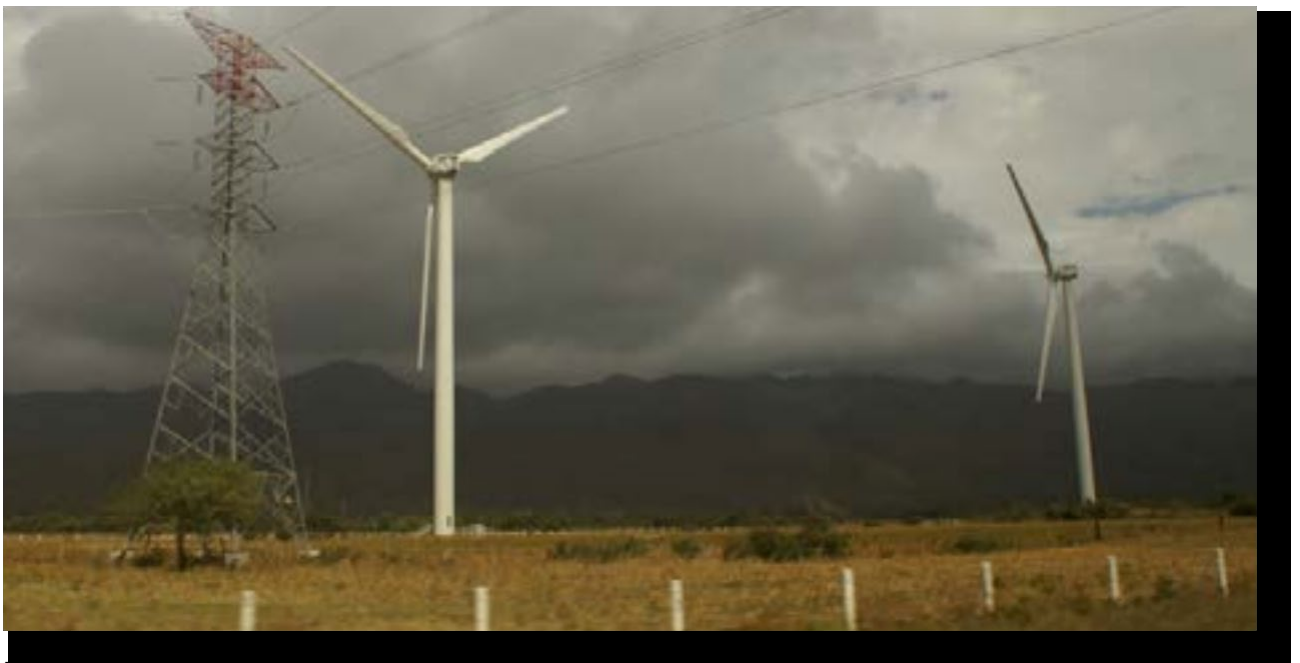
Figura 18. Parque Eólico “La Venta”, Oaxaca, México
