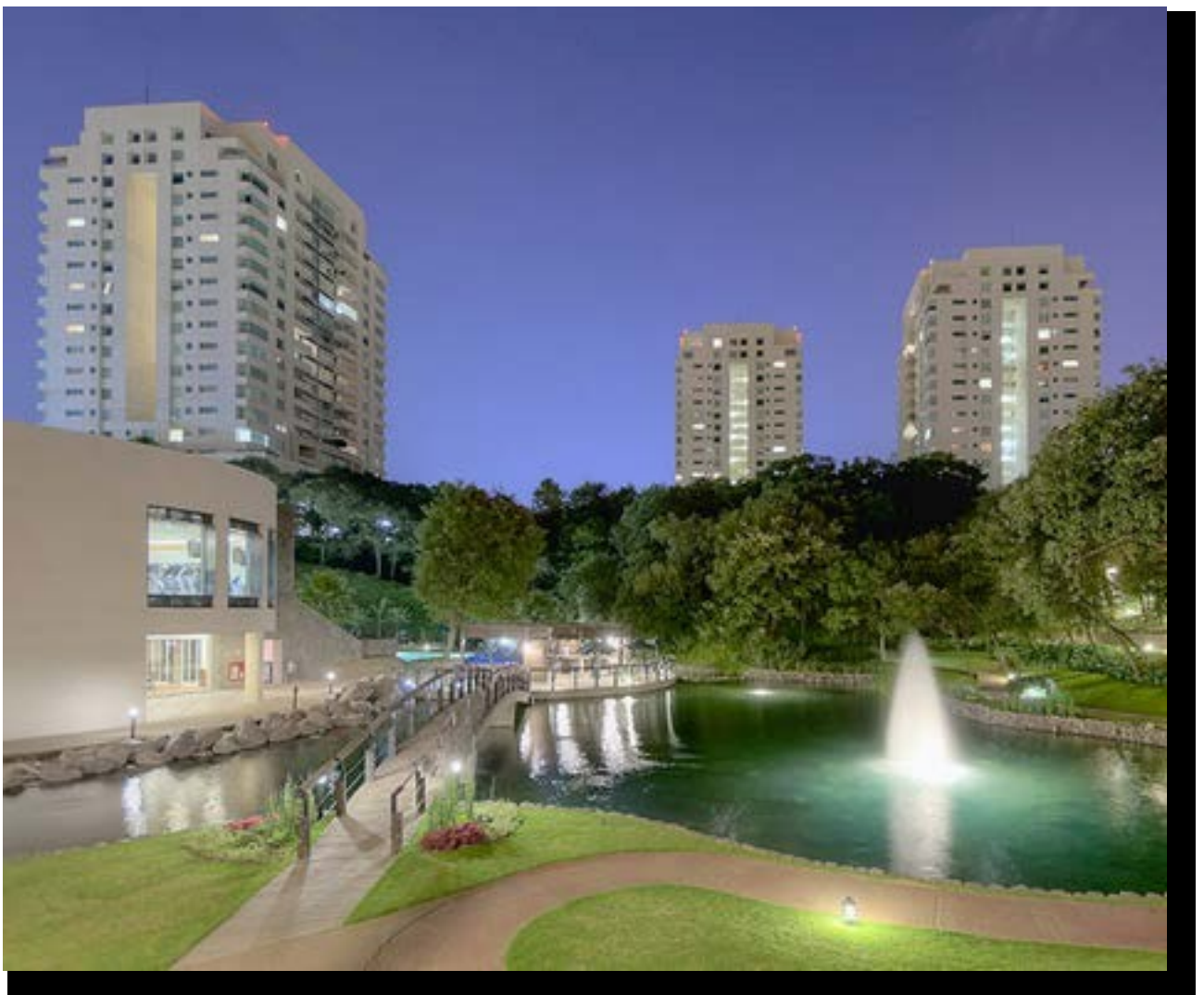
Figura 1. Conjunto Residencial “La Enramada”, ubicado en Lomas Country Club, Huixquilucan, Estado de México.
