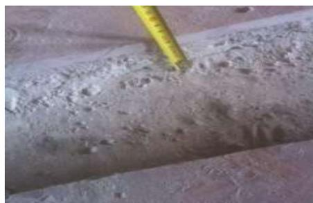
Figura 48: Roza o zanja de canalización de cableado en pavimento
