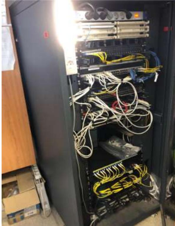
Figura 47: Armario "rack" situado en el centro de cableado más próximo a la infraestructura de red
