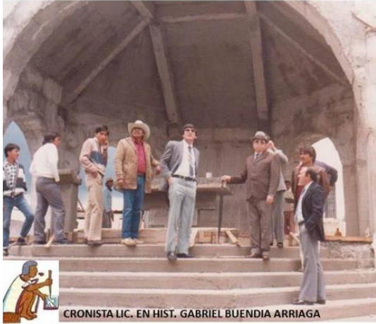
Fig. 24. Capilla abierta en construcción. 1988
