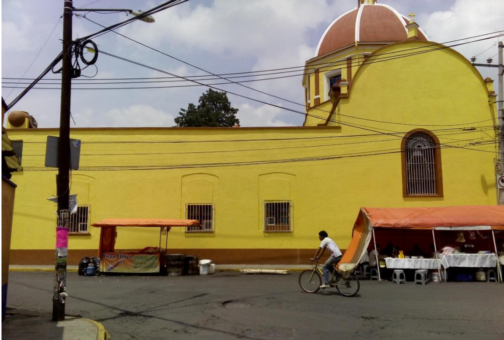
Fachada oriente del templo
