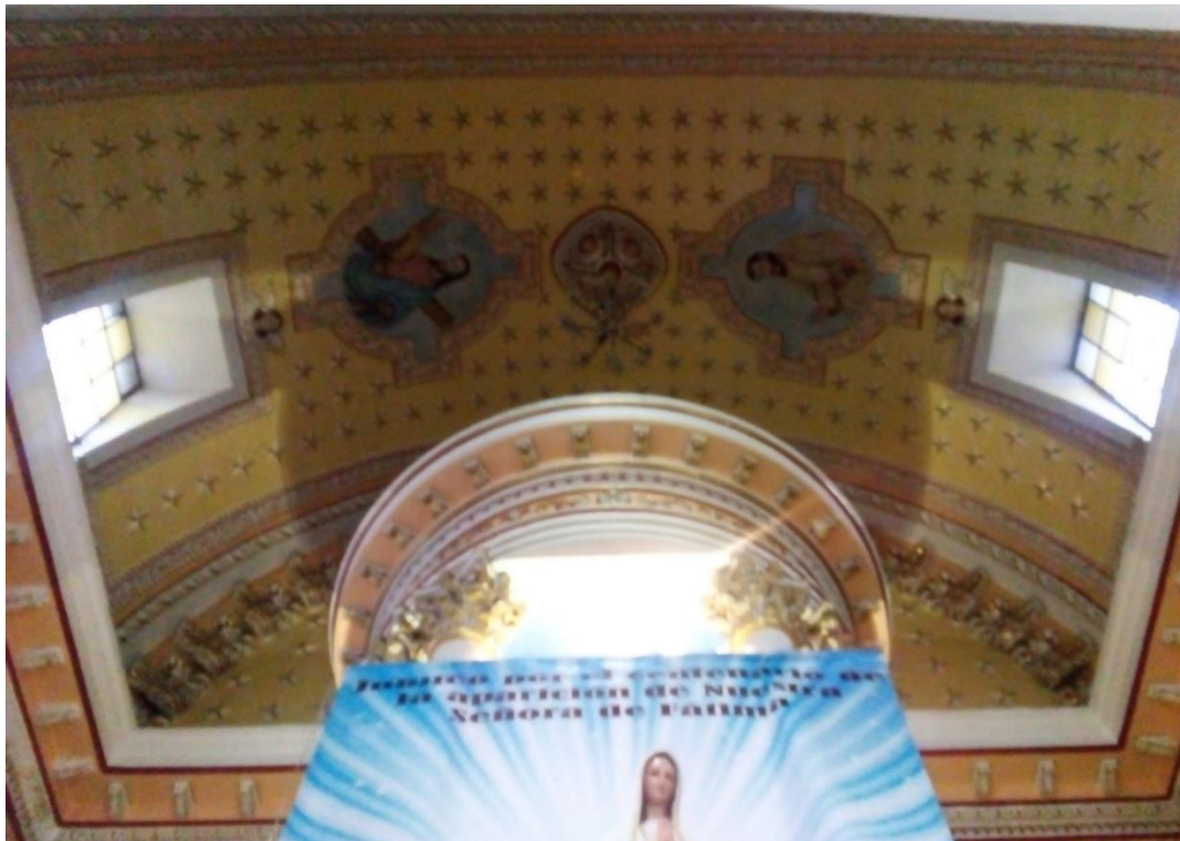
Bóveda del presbiterio
