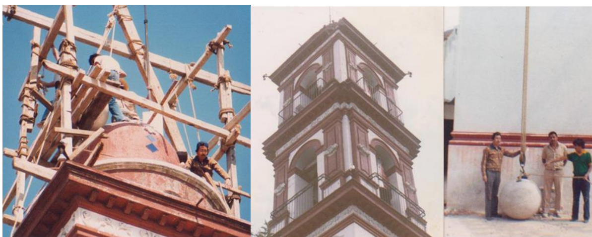
Fig. 22. Andamios sobre el campanario Fig. 23. Colocación del nuevo remate esférico 1985
