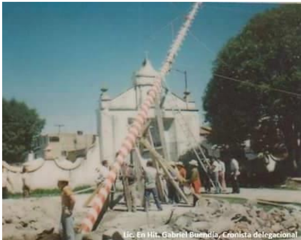
Colocación del poste de los voladores de Papantla
