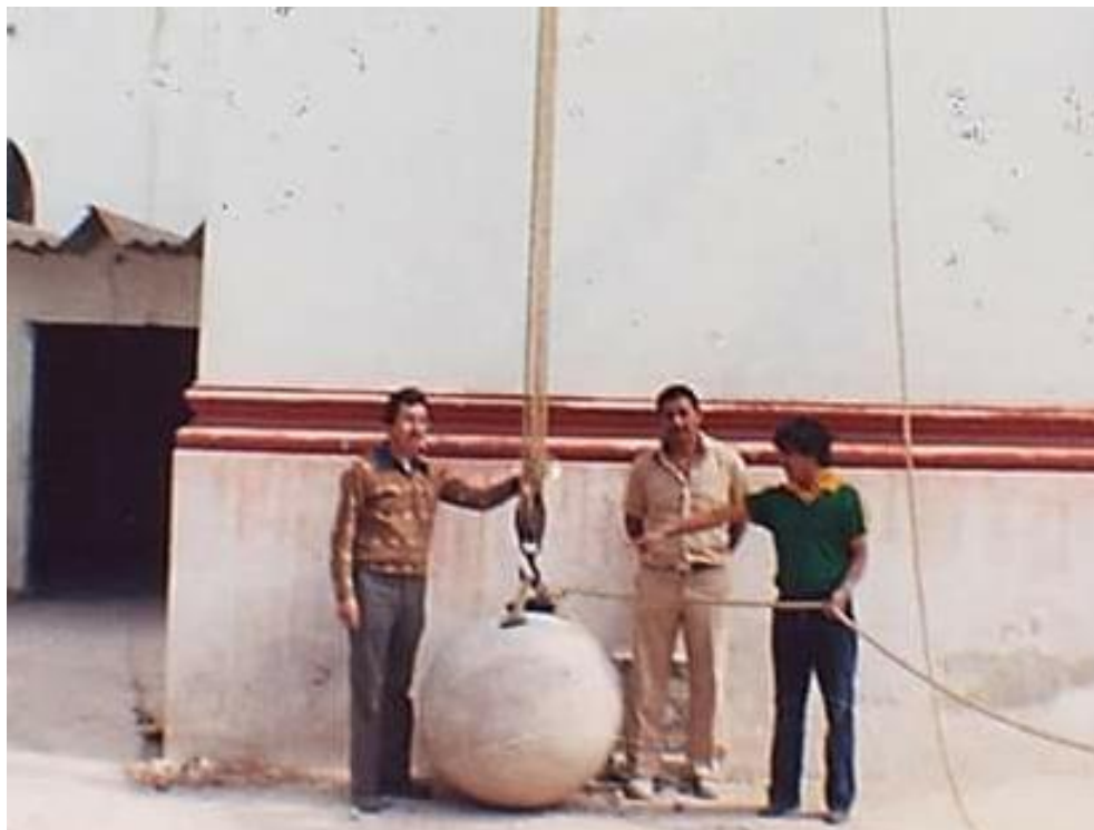
Colocación de un nuevo remate a la torre campanario
