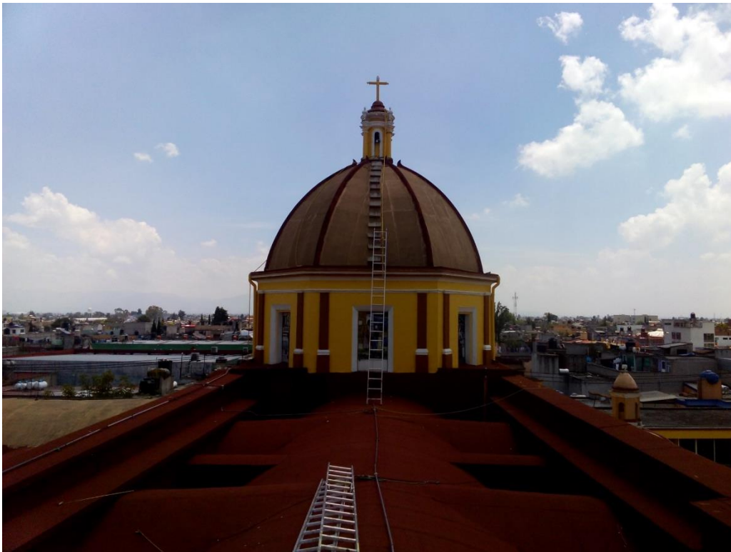
Cúpula y azotea de la nave central.
