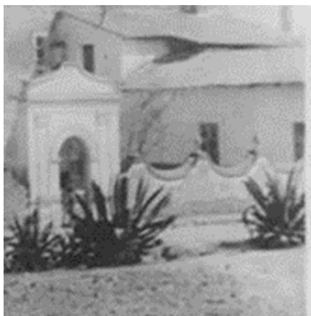
Fig. 18. Casa cural demolida en 1967
