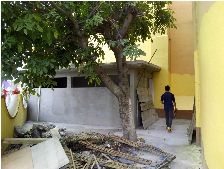
Sanitarios en construcción.
