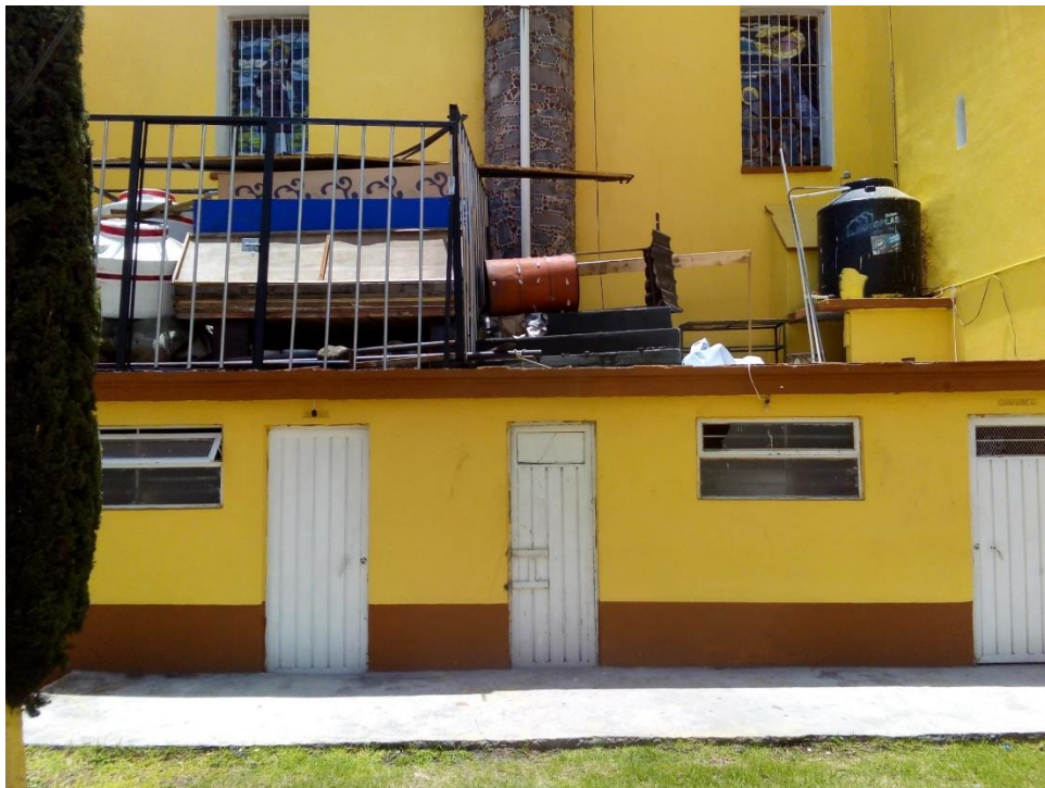
Sanitarios, bodegas y bajadas de agua existentes
