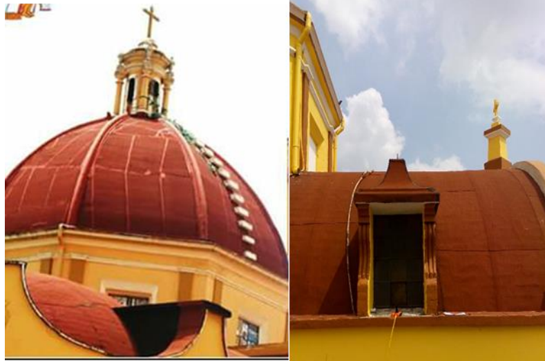
Fig. 32. Trabajos de impermeabilización en la cúpula y bóvedas del templo
