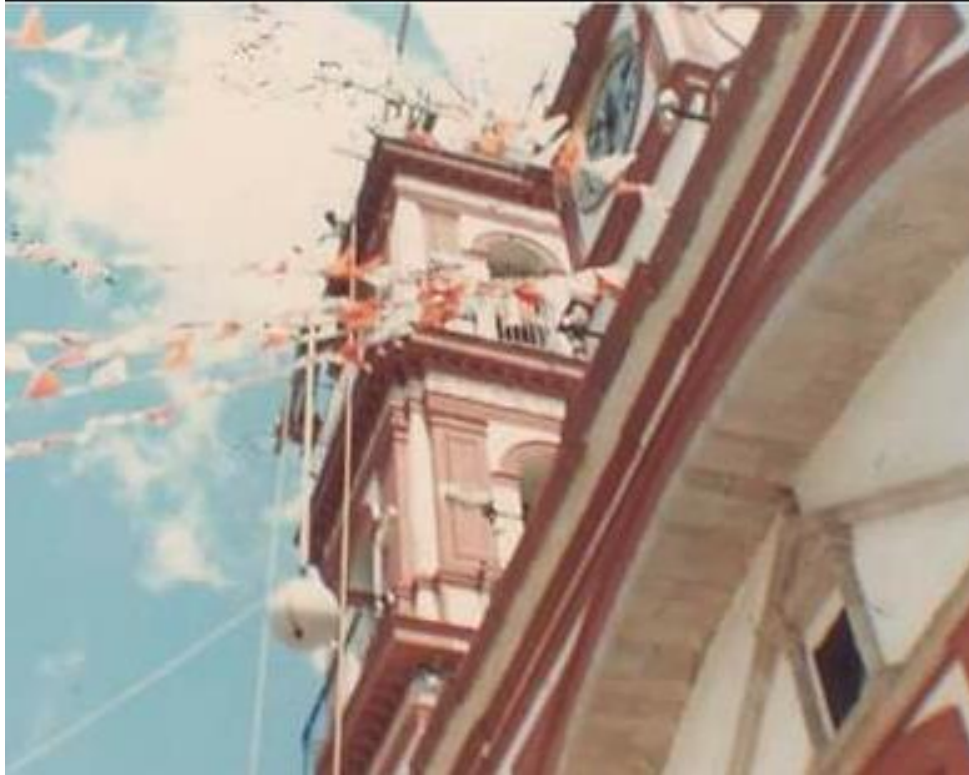
Elevacion del remate esférico a la torre. 1985
