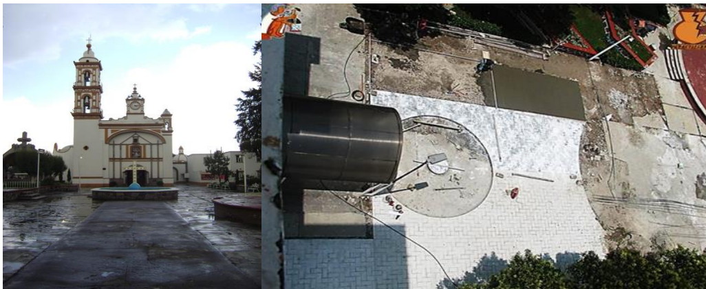
Fig. 34. Antigua fuente atrial. / Trabajos del nuevo piso en el atrio.
