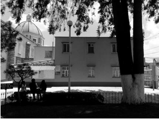
Fig. 19. Nueva casa curial que sustituyó a la demolida en 1967
