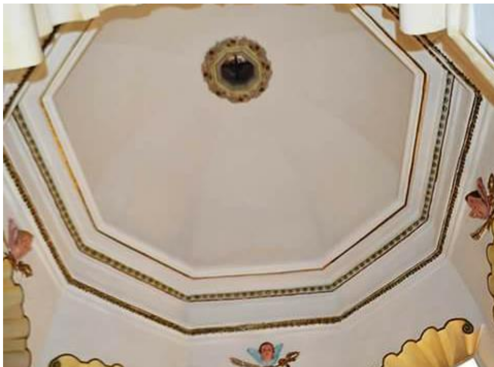
Interior de la cúpula del baptisterio
