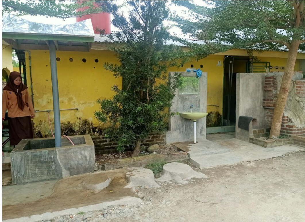
Gambar 1.6 Kondisi Toilet Siswa dan Guru MA Muhammadiyah 13 Sei Rampah
