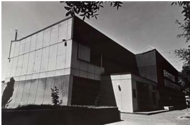
4 Nombre de la obra: Liceo Agrícola y Enológico Domingo Faustino Sarmiento Comitente: Universidad Nacional de Cuyo Ubicación: Parque General San Martín, Mendoza Año proyecto / año ejecución: 1982 c Fuente / fotógrafo: Centro de Documentación Histórica Edmundo Correas, UNCUYO
