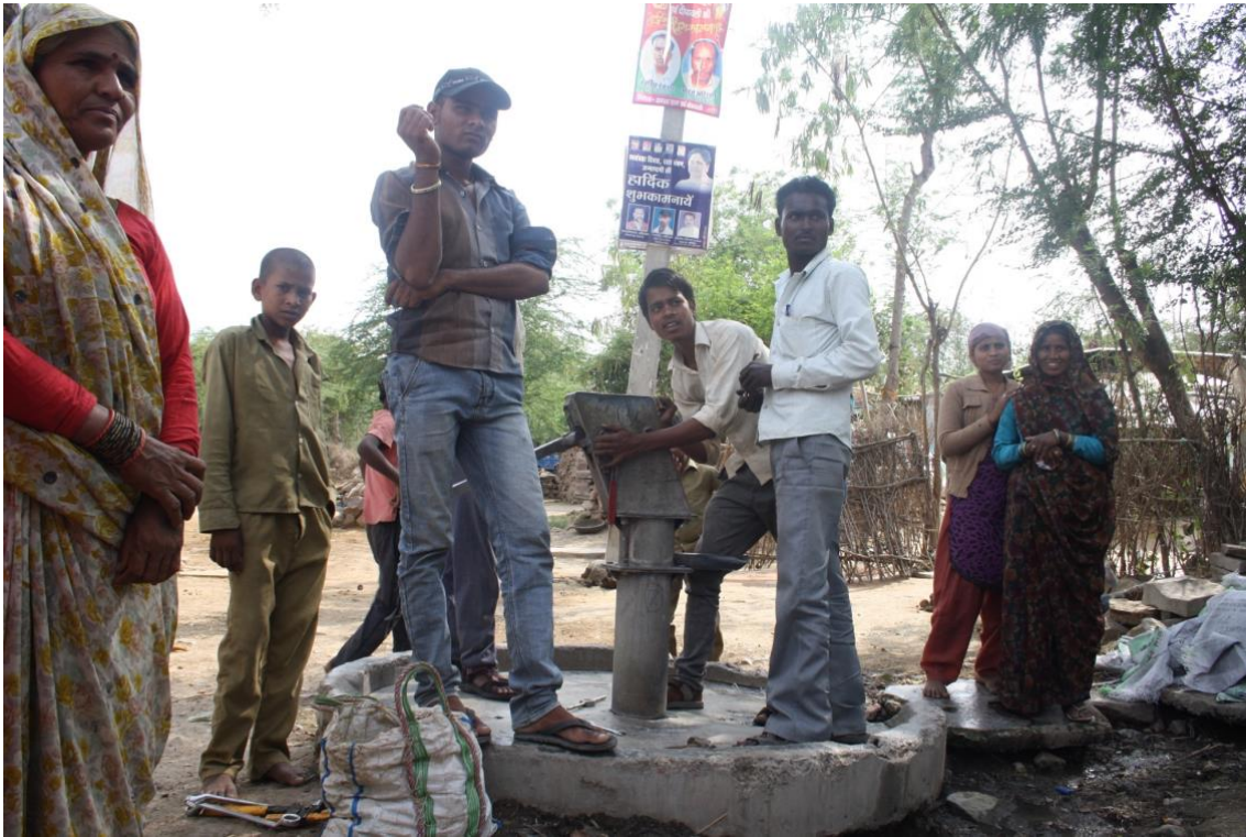
Fotografía 14: Trabajos de reparación de una bomba de agua en una población en la región de Bundelkhand.
