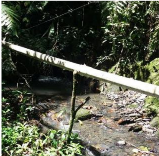
Imagen 38. Evidencia de un soporte existente en la conducción.
