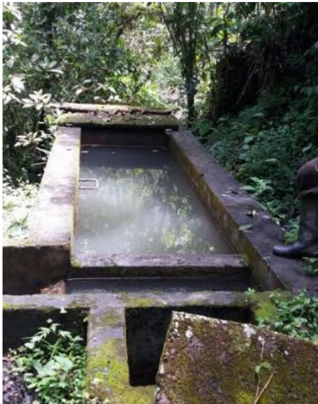
Imagen 35. Vista longitudinal del desarenador.
