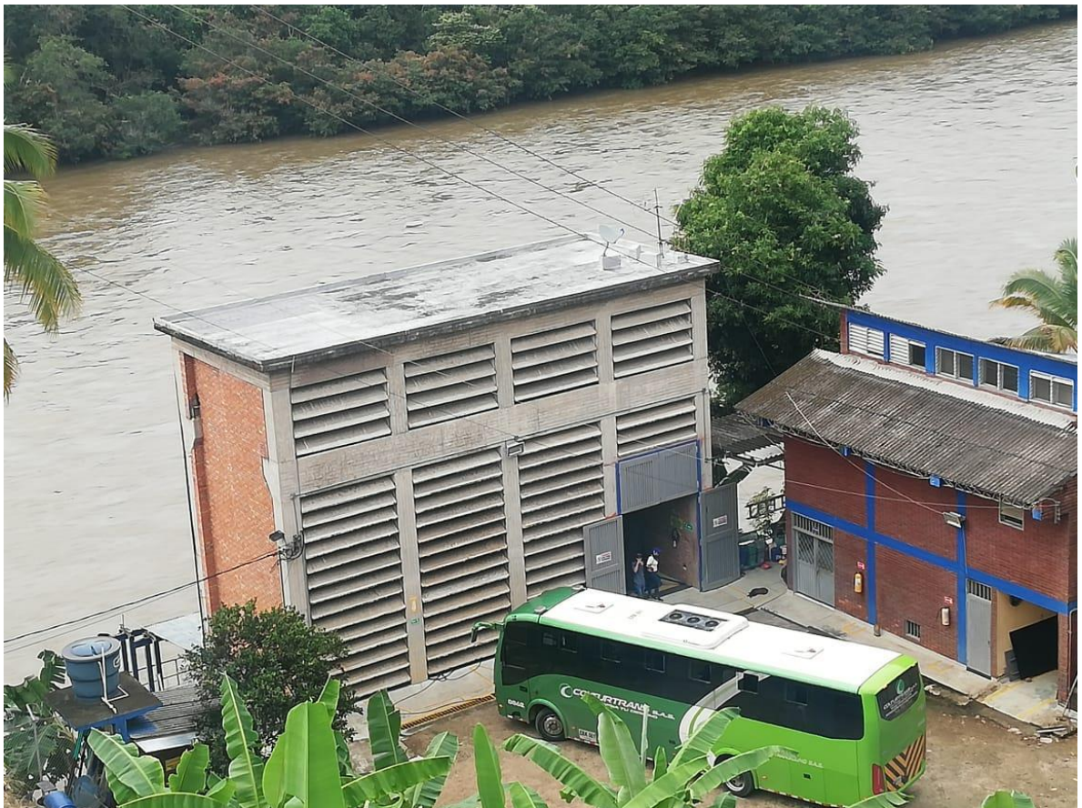
Ilustración 21 Sistema de captación, Asojuncal, El Juncal, Palermo, Huila
