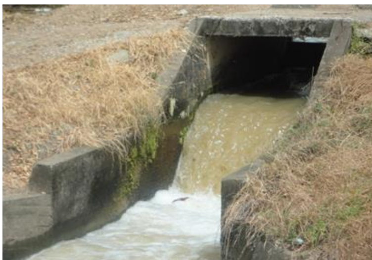
Ilustración 26 Caída Hidráulico, Asojuncal, El Juncal, Palermo, Huila
