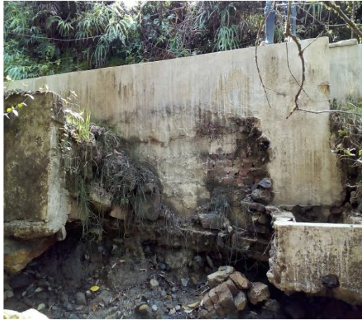
Ilustración 20 estructuras de captacion base completa de sedimentador
