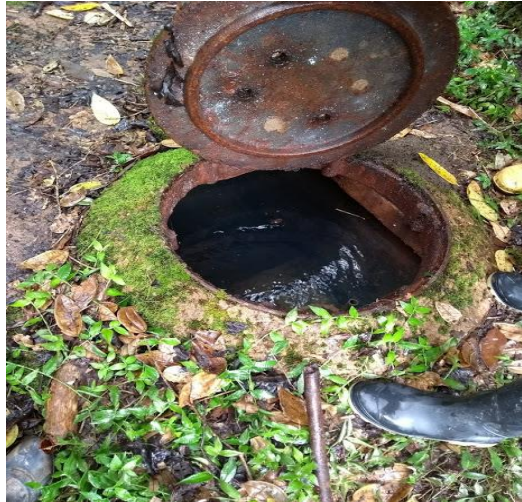
Ilustración 10 Fuente de captación Don Donato
