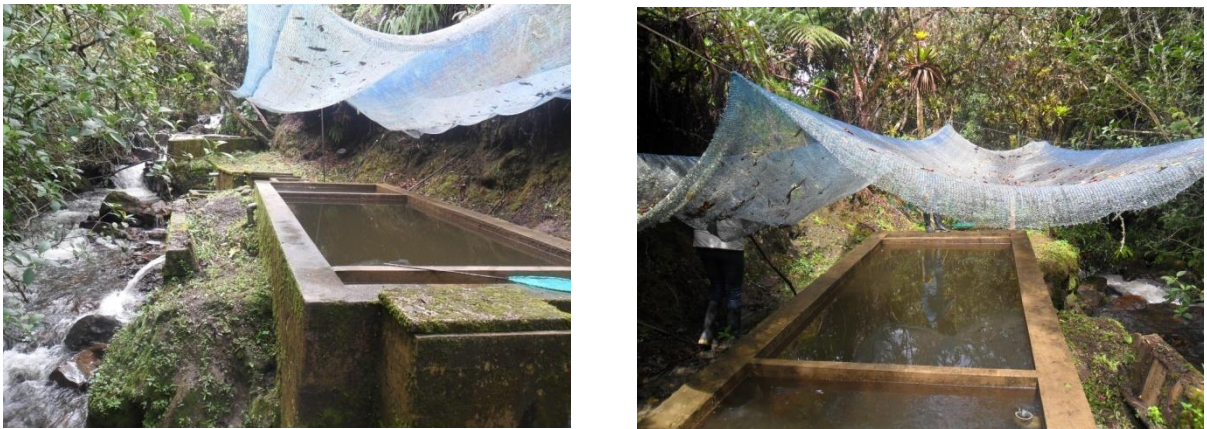
Ilustración 11 Desarenador quebrada el Hato
