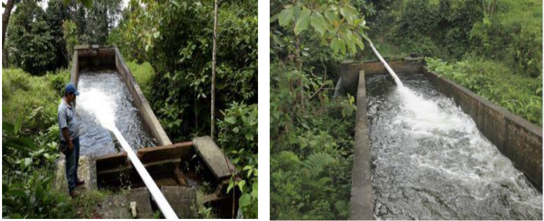
Ilustración 26. Desarenador laguna del Indio
