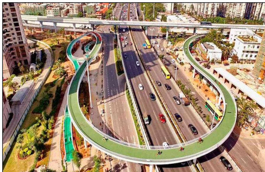
Ilustración 5 CicloRutas elevada en China
