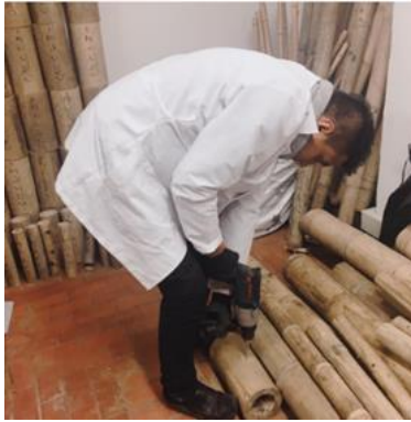
Figura 24. Perforación de la guadua.
