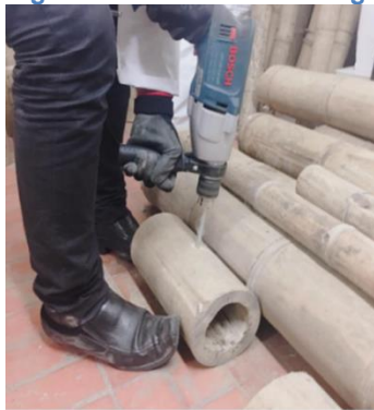
Figura 25 Perforación de la guadua modelo 2.
