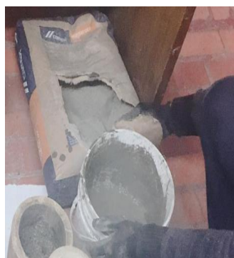
Figura 26. Realización de la mezcla.
