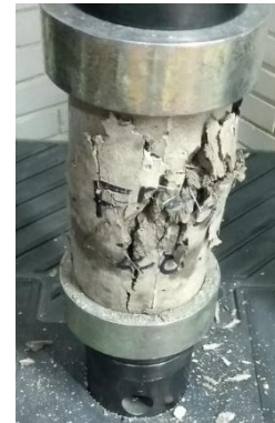
Figura 45. Cilindro de concreto reforzado con fibra de PET. FP6 después de ensayo a compresión.
