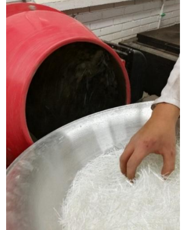
Figura 7. Adición de fibras de cáñamo en la mezcla de concreto.
