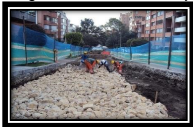
Imagen 38. Relleno de Rajón
