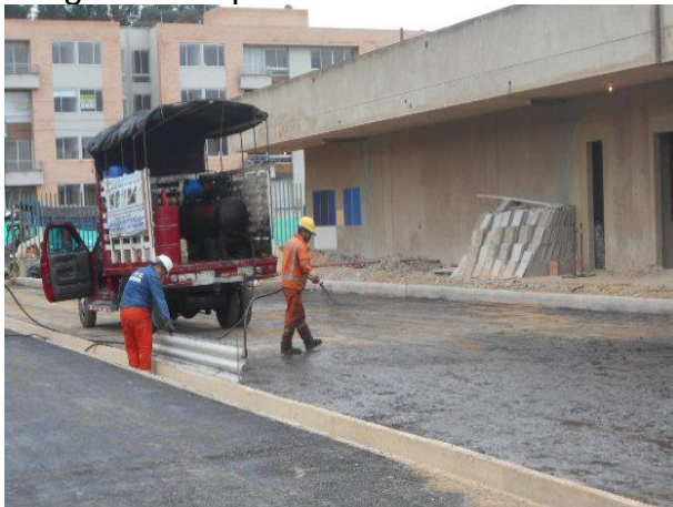
Imagen 44. Imprimación Asfáltica
