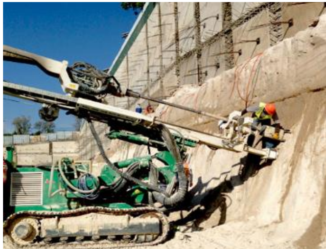
Imagen 10 Muro anclado Derco.
