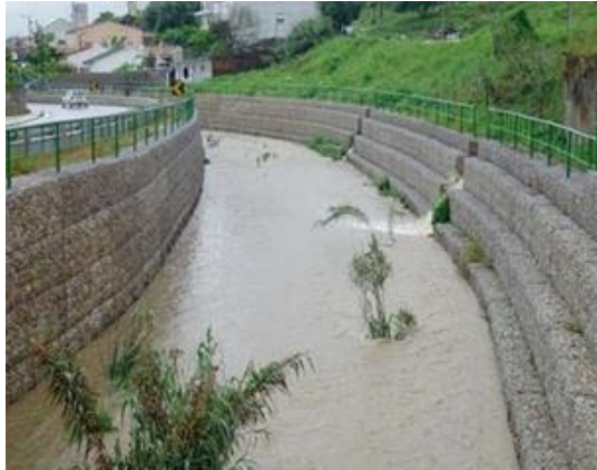
Imagen 14 Muro de contención en gavión.
