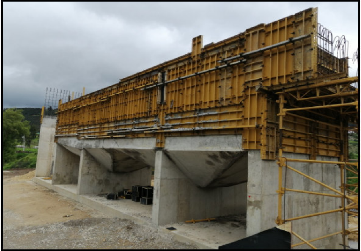
Figura 37. Construcción de desarenador.
