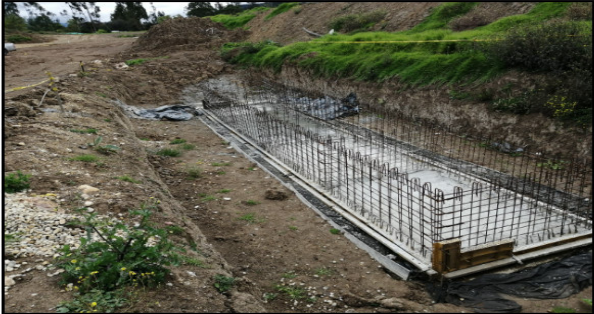
Figura 38. Construcción de lecho de lodos.
