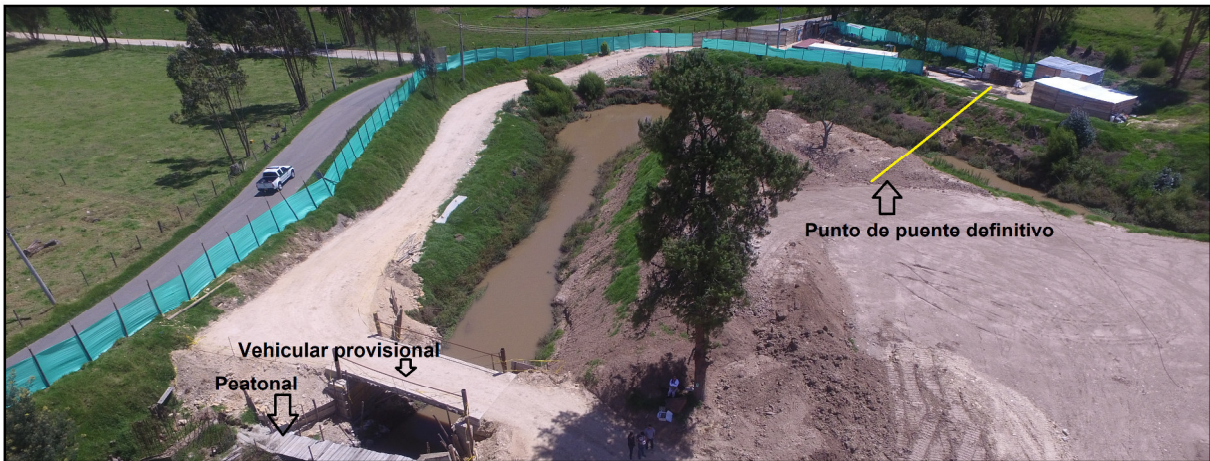
Figura 32. Puente de acceso provisional al predio.
