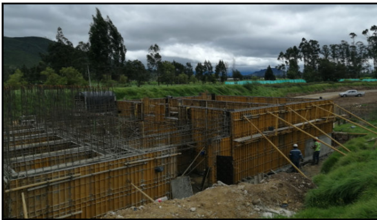
Figura 36. Construcción de tanques de desinfección y agua potable.
