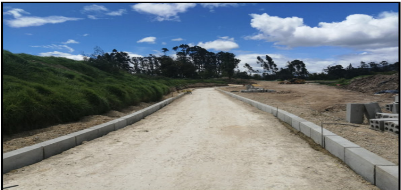
Figura 39. Construcción de vías internas.
