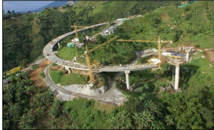
Figura 3. Viaducto Helicoidal - Entre Dosquebradas y Santa Rosa.
