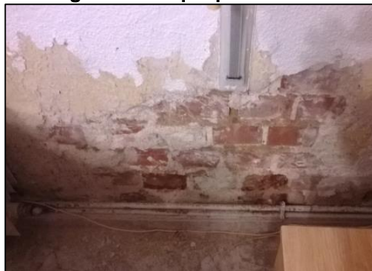
Figura 7. Ataque por Sulfatos
