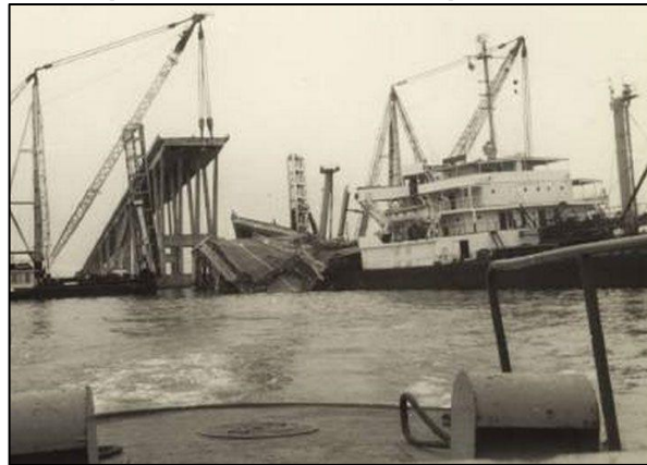
Figura 4. Choque de barco contra el puente de Maracaibo.
