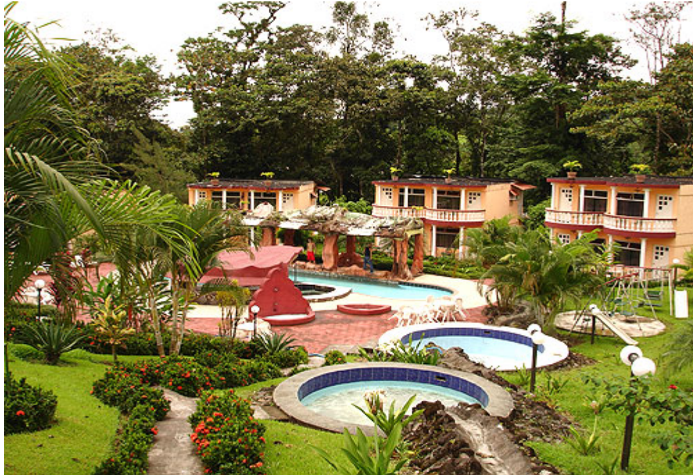
Figura 3.2 Fotografía Hotel Cataratas Eco Resort
