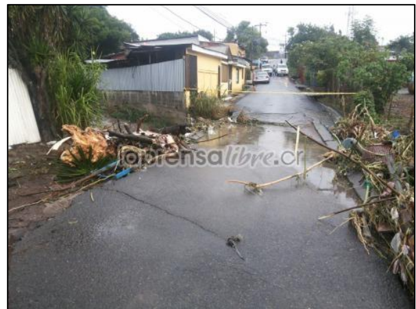
Figura 11. Afectación puente Pinares
