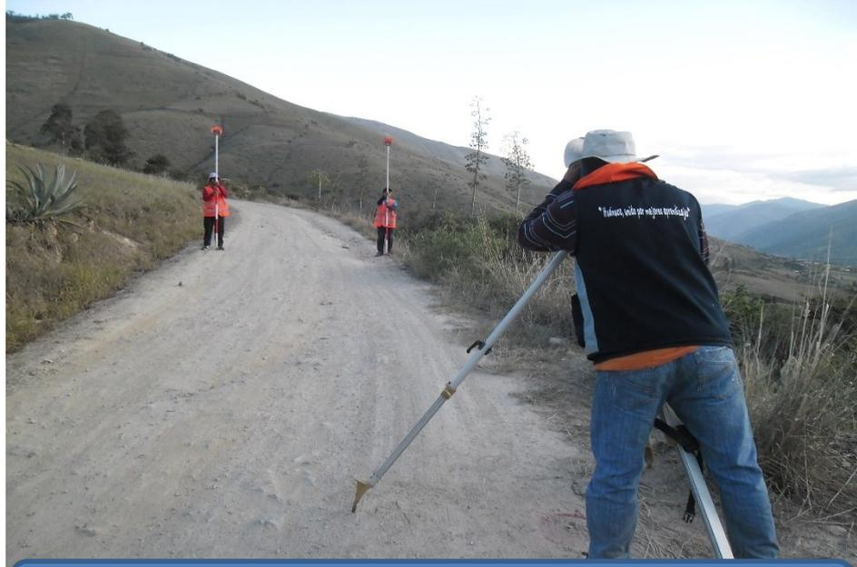
Levantamiento topográfico de la calzada
