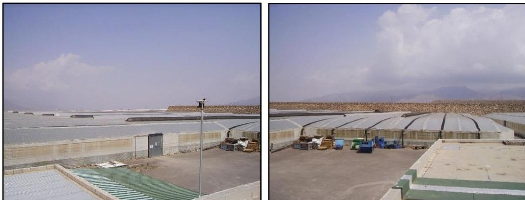
Figuras 29 y 30. Detalle del invernadero. Tipo “raspa y amagado”.
