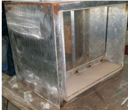
Figura 12. Modulo en construcción.
