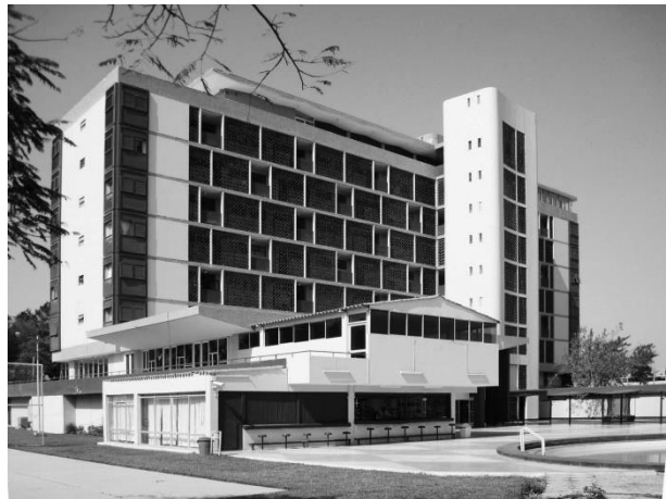
Imagen 67: Fachada posterior de la Residencial FAP. Fuente: Archdaily
