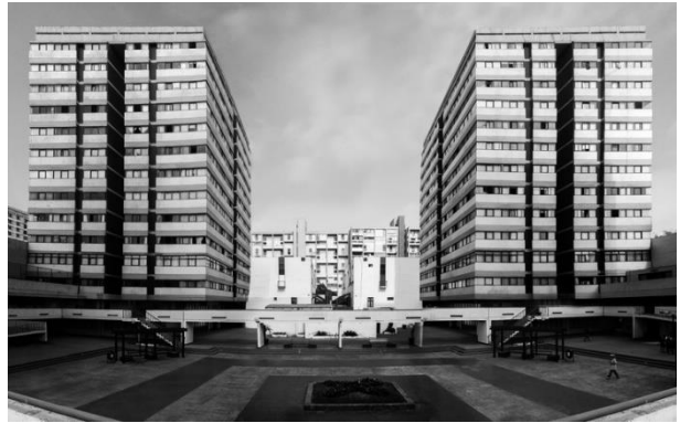
Imagen 60: Torres de catorce niveles de la Residencial San Felipe. Fuente: Archdaily
