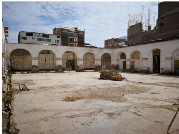
Imagen 109: Vista del patio central del Ex Convento Santa María. Fuente: Propia
