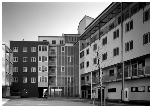
Imagen 85: Vista desde uno de los patios de Frauen Werk Stadt Vienna. Fuente: Blog La ciudad viva
