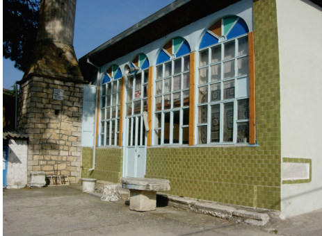
Fig. 22. Cami Girişi ve Duvarındaki Mimari Elemanlar
