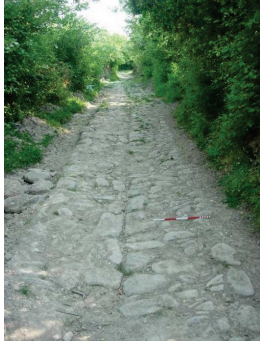
Fig. 18. Taş Döşeli Bağ Yolu
