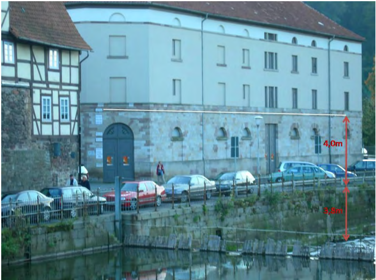
Abb. 36: Hochwasserstand im Juli 1342 am Haus Packhof in Hannoversch Münden (Foto A. Beyer, 2007)
