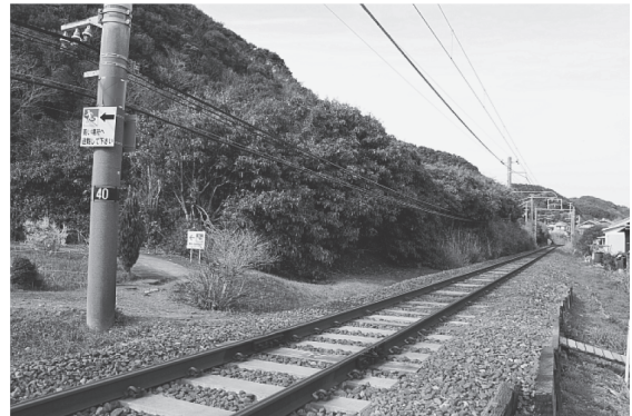
図5 「高い場所へ避難して下さい」と表示された線路外出口標および自治体が線路外に設置した避難場所への誘導標識(串本駅付近)
