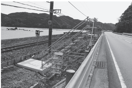
図6 線路内から道路へ避難するために設置された階段（下里・紀伊浦神間）
