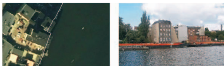
Rys. 6. Nachylenie budynków w kierunku wody (zdjęcie lotnicze).
