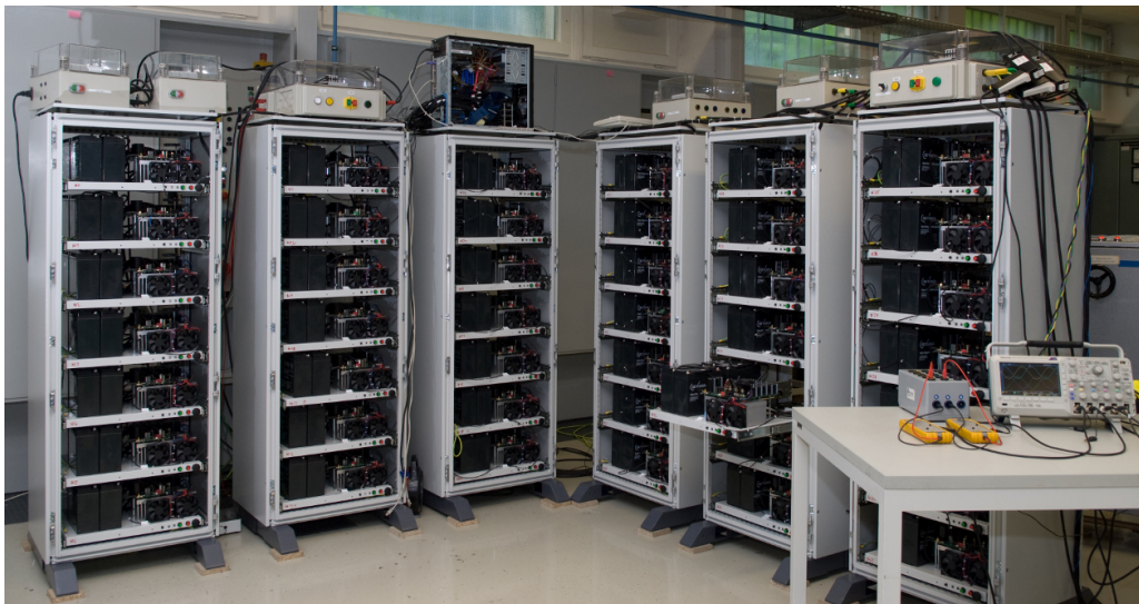
Abbildung 8.1: Aufbau des Hexverters im Labor des IAL
