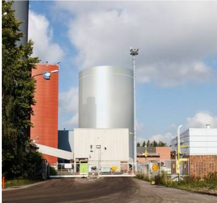
Kuva 5. Fortumin Suomenojan voimalaitokselle suunniteltu kaukolämpöakku. Vesisäiliön tilavuus 20000 kuutiota, johon voidaan varastoida 800 MWh lämpöenergiaa. Korkeus 43 metriä ja leveys 26 metriä. [47]
