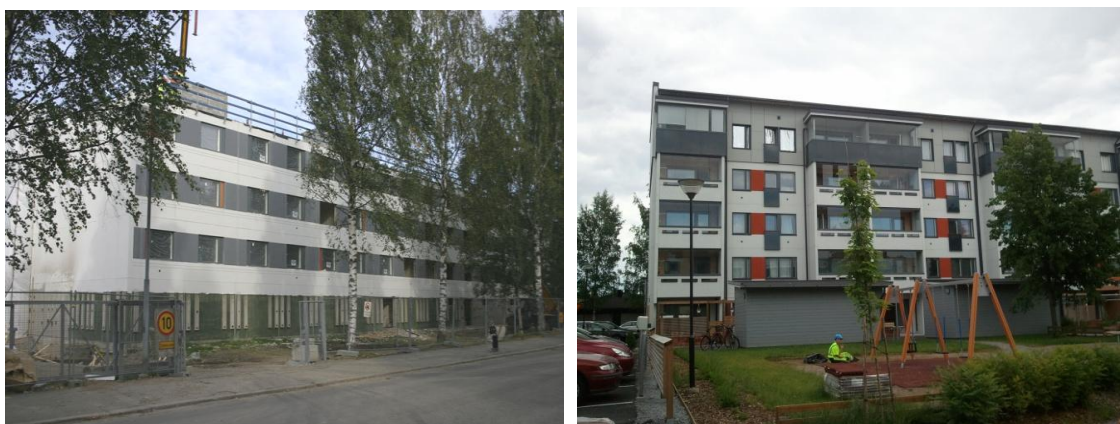
Kuva 1-2. Takuvainionkatu 4 ennen ja jälkeen perusparannuksen.
