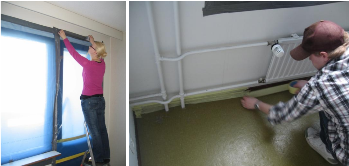
Kuvat 6.4 ja 6.5. Tiivistysteippauksia tehdään ikkunoihin ja ulkovaipan liitoksiin.
