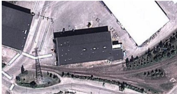
Kuva 8.1 Pituuspaketointilaitos, Kotka (kuva: google maps).
