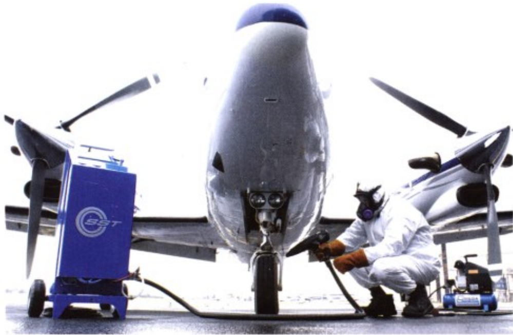
Kuva 9. Korroosiosta johtuvien pinnoitevaurioiden korjaamista kentällä [16, s. 37].
