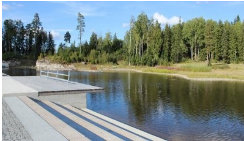
Kuva 18: Hulevesiallas Tampereen Vuoreksessa. Virkistyskäyttö huomioitu rantaratkaisulla. (Vuores Palvelu Oy)
