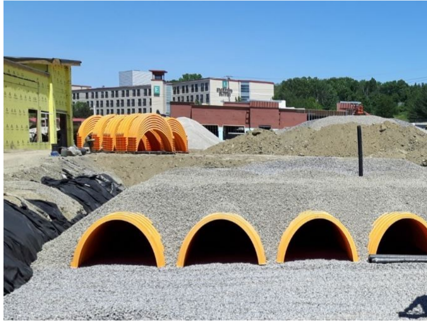
Kuva 15: Oy ViaCon Ab:n StormTech-hulevesitunneli huleveden viivyttämiseen ja imeyttämiseen. Ratkaisu kestää suuria kuormia ja soveltuu siksi myös liikennöityjen alueiden alle. (Oy ViaCon Ab)
