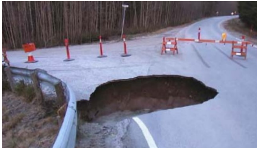
Kuva 9: Paineellisen pohjaveden aiheuttama eroosio ja tien sortuminen. (Liikennevirasto, 2010)
