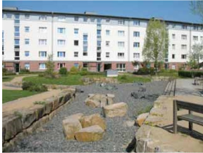
Kuva 13: Avoin imeytyskaivanto piha-alueella. (Hulevesiopas 2012, s. 150)
