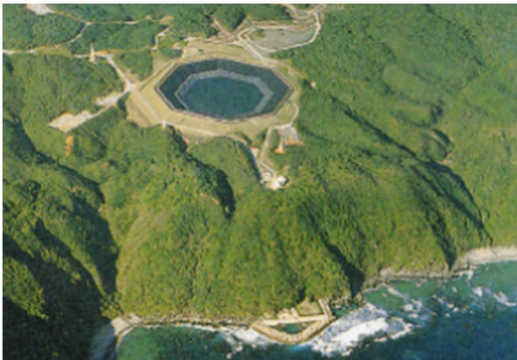
Kuva 3.1.2: Okinawan saaren merivettä käyttävä pumpattava vesivarasto (Rehman et al. 2015).
