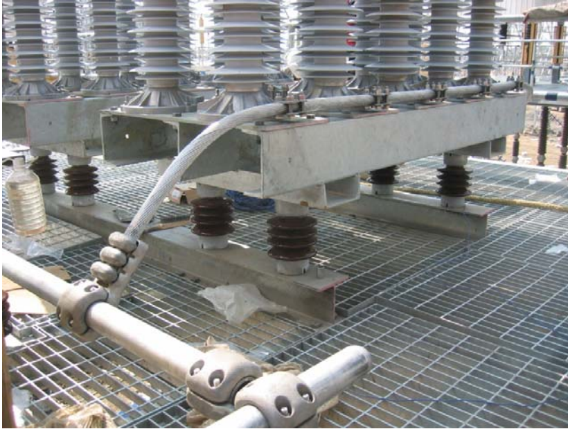
Kuva 2.2. Kuvassa näkyy laitteiden alla oleva palkkirakenne, eristimiä ja teräsritilä.
