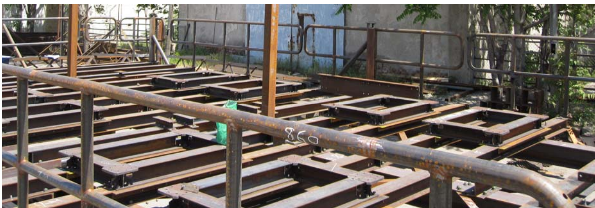
Kuva 2.1. Kuvassa näkyy teräspalkkien asettelu lavassa.
