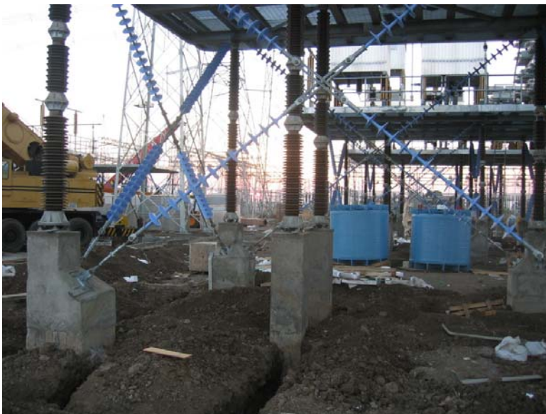
Kuva 2.3. Kuvassa näkyy lavan alla olevat posliiniset pystyeristimet ja komposiittiveto-harukset.
