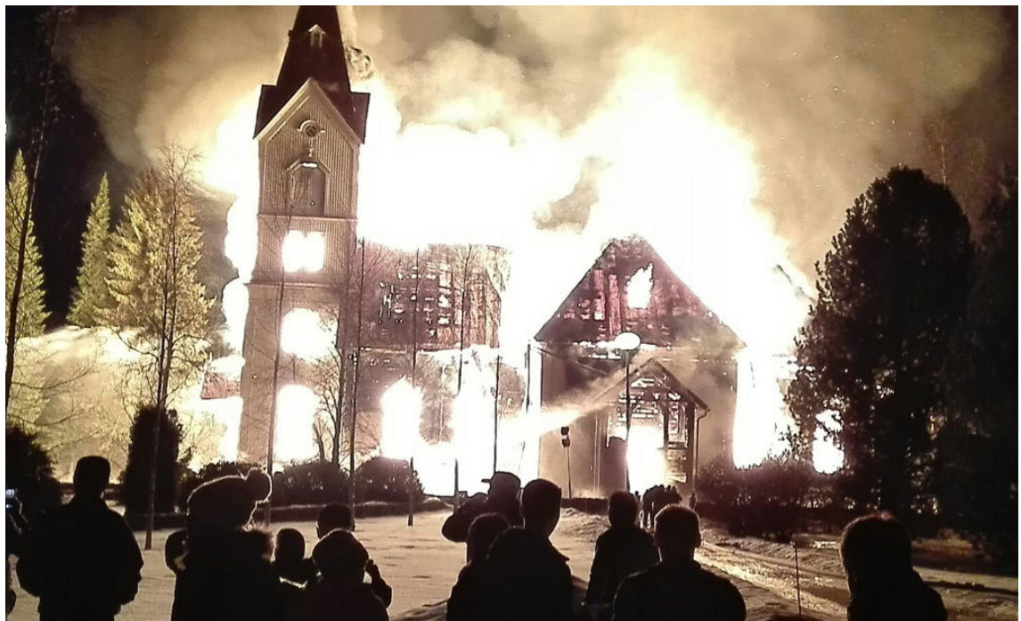
Kuva 3.4. Järkyttyneet seurakuntalaiset katsovat Ylivieskan palavaa kirkkoa (Iltalehti 2016).
