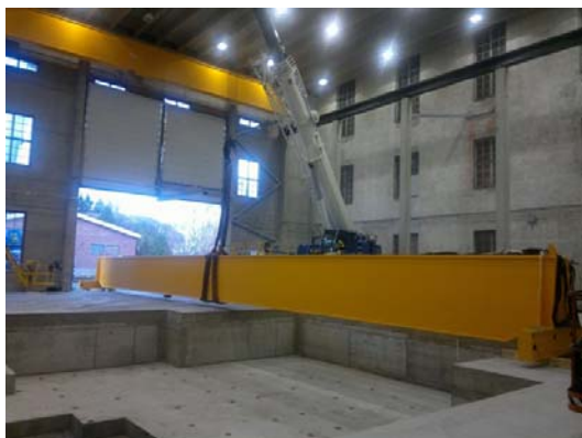
Kuva 7.4. Nosturiasennuksen ensimmäinen vaihe, jossa pääkannattajat nostetaan rekan lavalta hallin lattialle.
