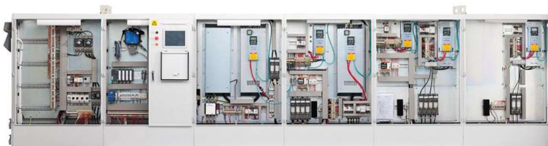
Kuva 2.9. Pohjakiinnitteinen, 1500 mm korkea sillankaappi.
