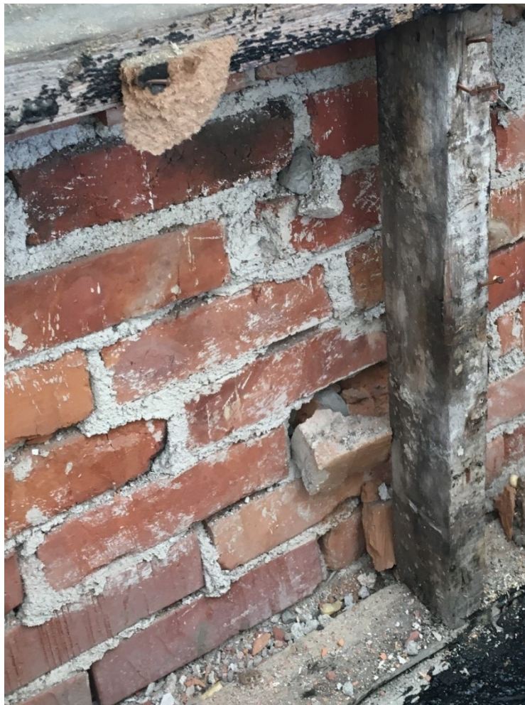
Kuva 18. Epätiivis tiilisisäkuori.
