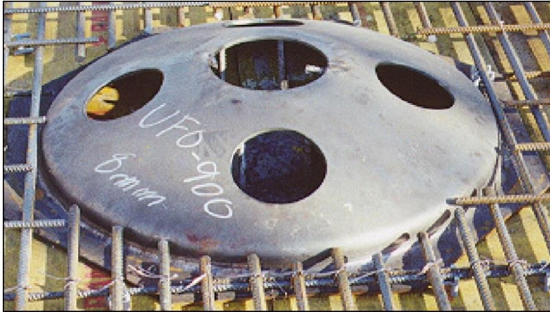
Kuva 2.9 UFO lävistysvahvike asennettuna [16]
