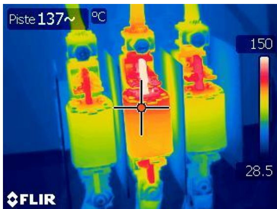
Kuva 44. Liitospintojen löystymisen aiheuttama lämmön nousu kahvasulakkeissa (© If Turvaakatemia).
