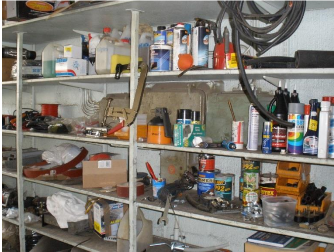
Kuva 36. Rungas palavieneiden varastointi jakokeskusten läheisyydessä (© Pertti Kukkonen, Oy Elspecta Ab).
