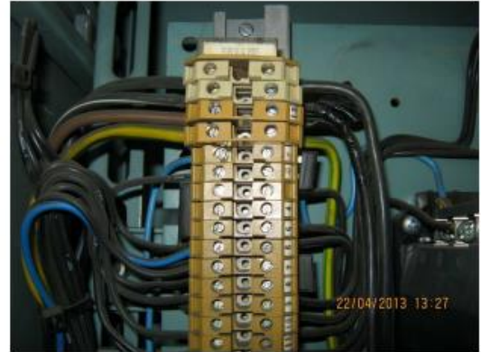
Kuva 42. Löystyneen riviliittinkytkenän vaikutus johtimen ja liittimen lämpötilan nousuun (© Hannu Halminen, Bolden Harjavalta Oy).
