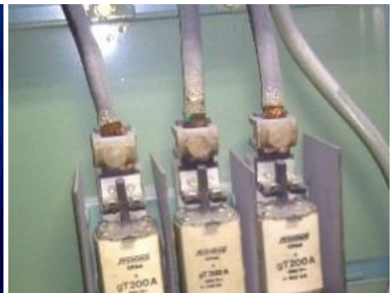
Kuva 44. Liitospintojen löystymisen aiheuttama lämmön nousu kahvasulakkeissa (© If Turvaakatemia).
