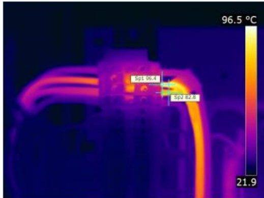
Kuva 42. Löystyneen riviliittinkytkenän vaikutus johtimen ja liittimen lämpötilan nousuun (© Hannu Halminen, Bolden Harjavalta Oy).
