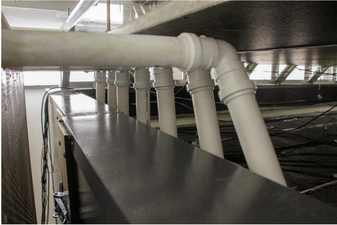
Kuva 6. Ilmavirtausputkien johtaminen koe-elementin tuuletusväliin.
