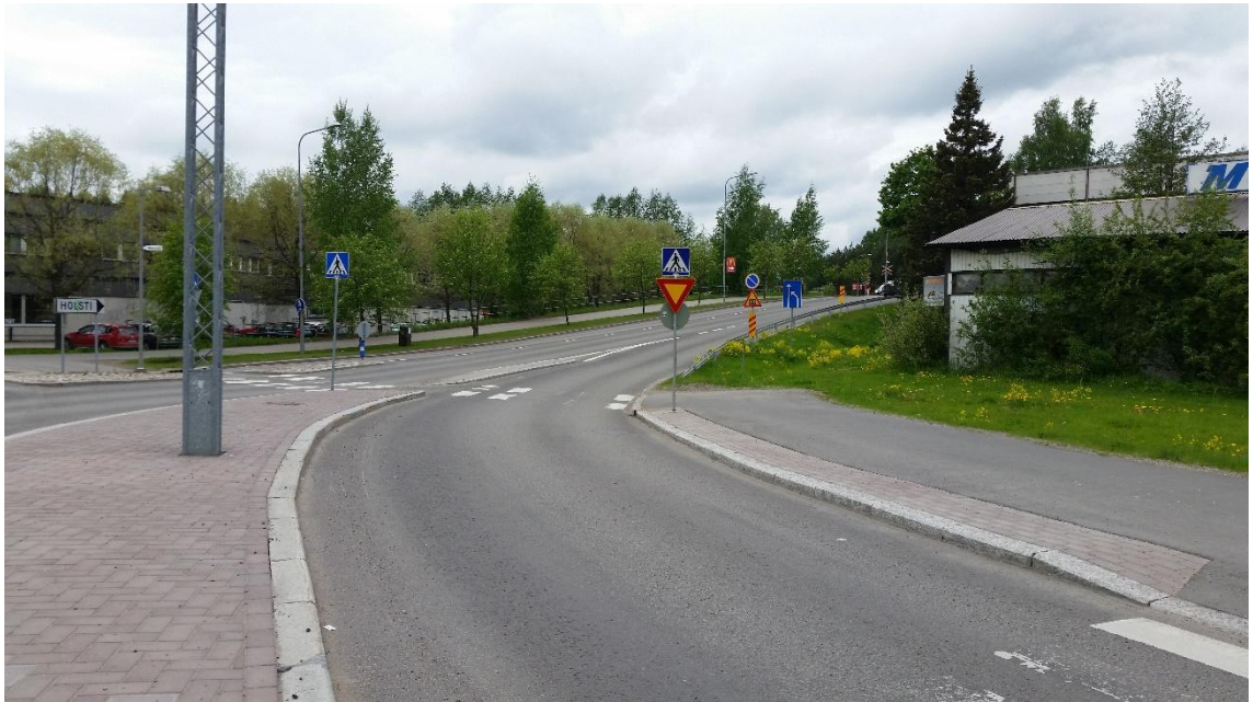
Kuva 33. Näkymä oikealle kääntymiskaistalta. Pyörätien linjaus kulkee ajoradan vieressä, jolloin autot lähestyvät pyöräilijän selän takaa.
