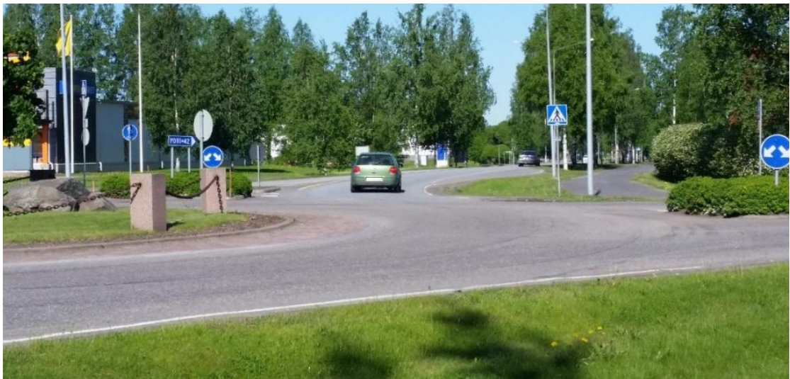
Kuva 20. Kauvatsantien kiertoliittymän poistumissuunta lännen suuntaan.
