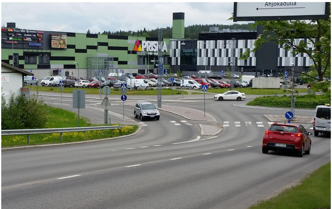
Kuva 9. Merasimen kiertoliittymän oikealle kääntymiskaista poistumissuunnalta kuvattuna.
