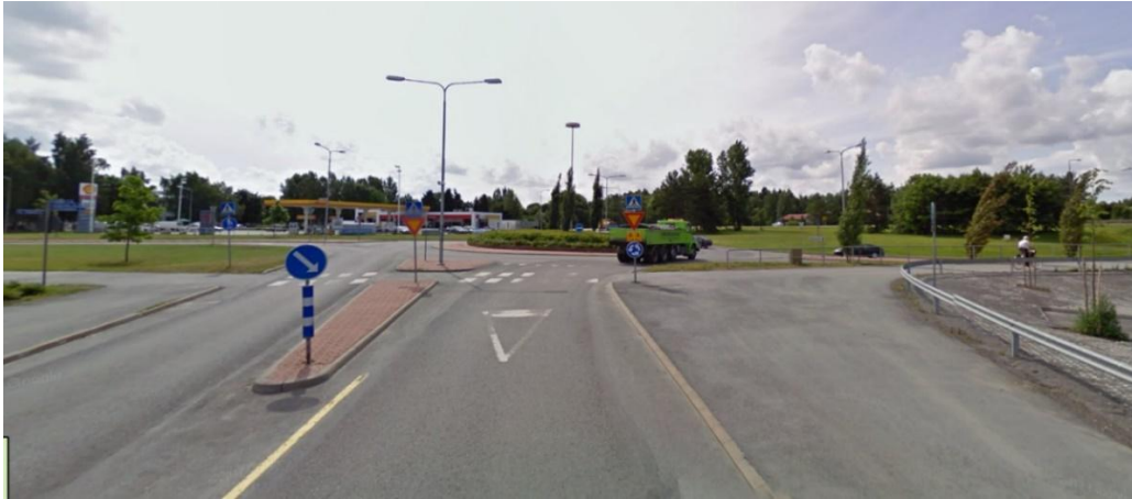
Kuva 29. Näkymä Tikkulan kiertoliittymään pohjoiselta liittymähaaralta. Kuvassa oikealla yhdistetty pyörätie ja jalkakäytävä on tarpeettoman leveä liittymää lähestyttäessä (Google Maps 2017).
