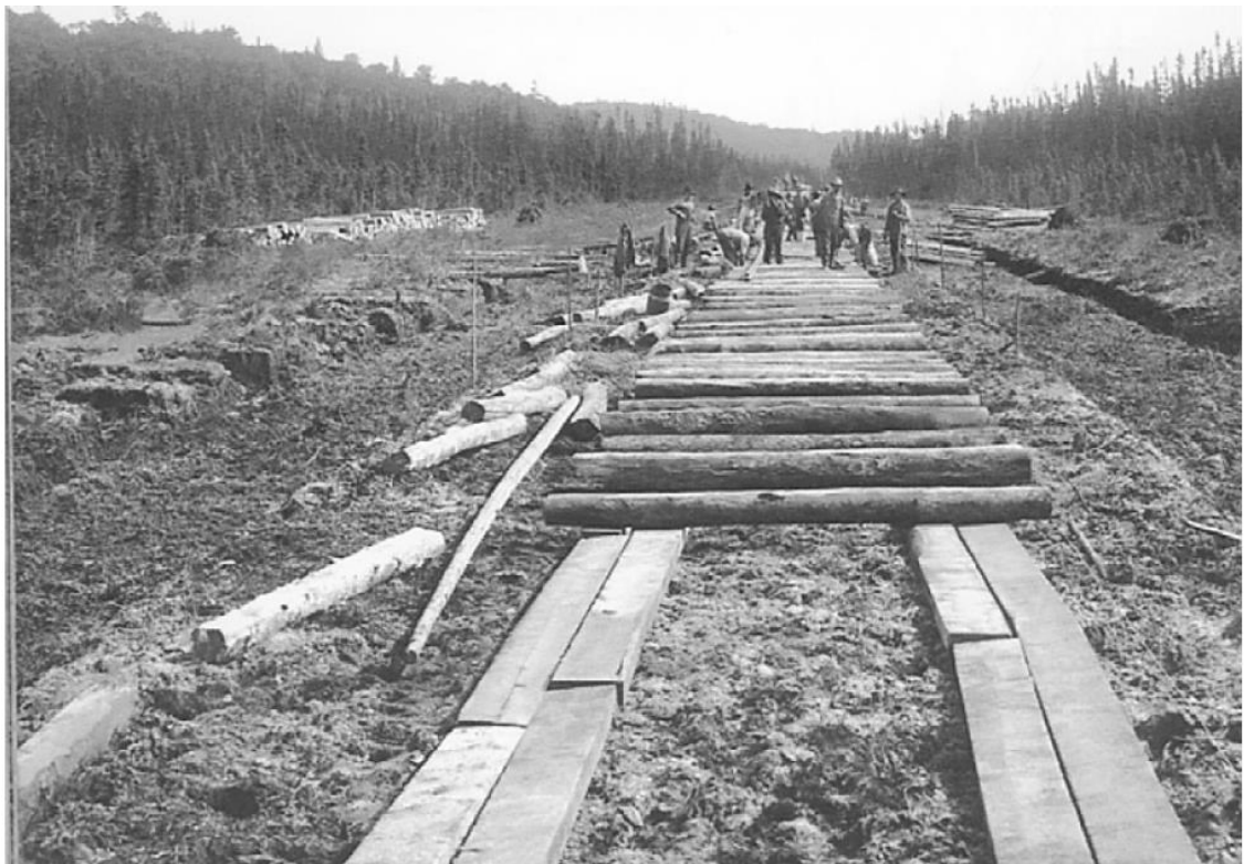
Kuva 34. Puuarinan rakentamista turvepohjamaalle (Hendry 2011).
