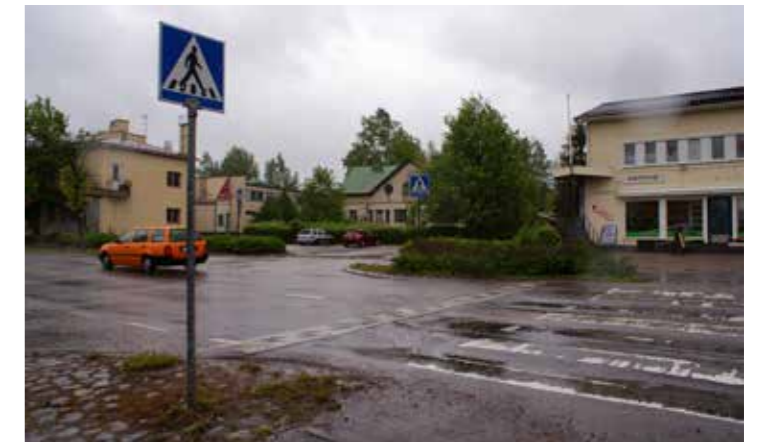
Korotettu suojatie kirpputorin edessä.
