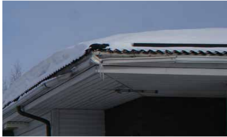
Yläpuolella: R-kioskin räystäskourut ovat vääntyneet.
