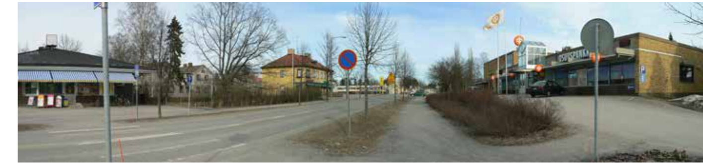
Ajouradan molemmin puolin kulkevat kasvillisuuskaistaleet. Kuvassa kaistale erottaa myös jalkakäytävän ja pankin pihan toisistaan.
