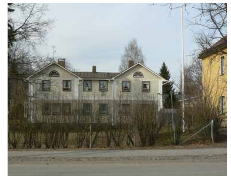
Entinen apteekki sijaitsee viistosti entisen yhdyspankin takana (keltainen rakennus, jonka kulma on kuva oikeassa reunassa).
