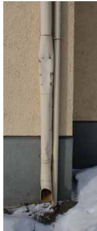
Yläpuolella: R-kioskin räystäskourut ovat vääntyneet.
