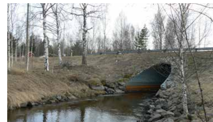
Huitilanjoki alittaa tien metallisen tierummun kautta.
