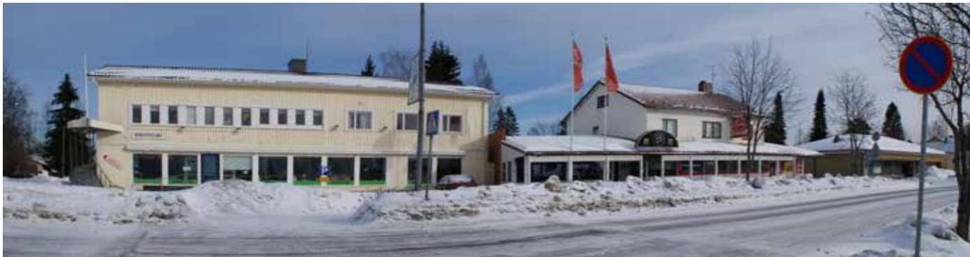
Kuvassa on esimerkki rakennuskokonaisuudesta, jolle ei ole määritetty erityistä arvoa. Kaksikerroksiset rakennukset ovat aiemmin olleet erillään. Yksikerroksinen yhdistävä laajennus on tehnyt kokonaisuudesta varsin merkittävän. Yksittäin rakennukset toimisivat mainiosti, mutta laajennus heikentää niiden arkkitehtuuria merkittävästi. Niillä on kuitenkin tärkeä rooli keskusraitin rajaajina ja ne kertovat myös paikallisesta historiasta.
