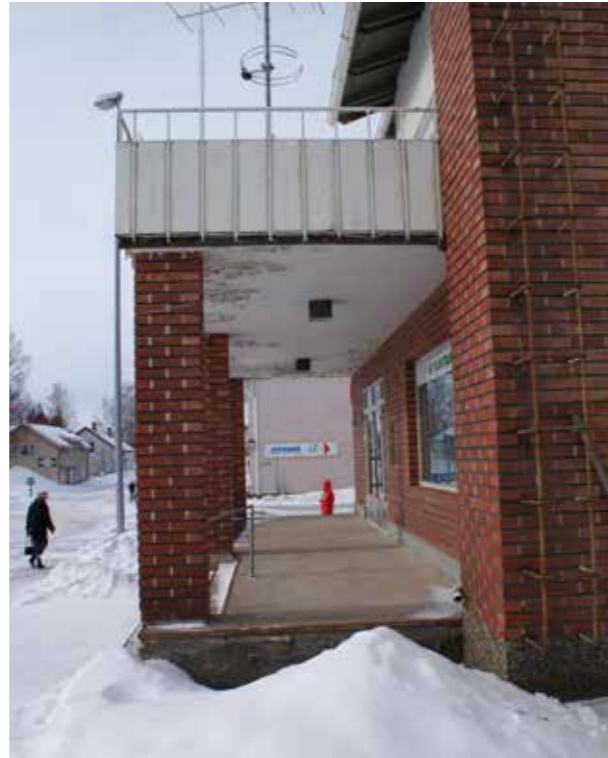
Yläpuolella: R-kioskin räystäskourut ovat vääntyneet.
