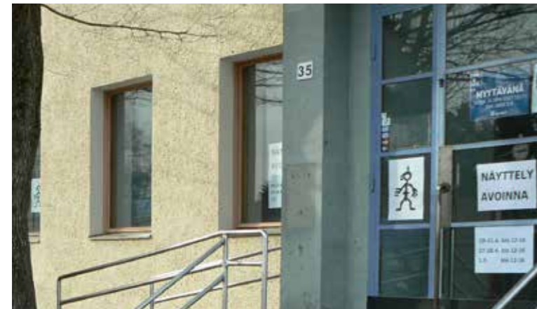
Entisen Säästöpankin liiketilassa on väliaikaista näyttelytoimintaa, mutta muutoin se on tyhjiillään.
