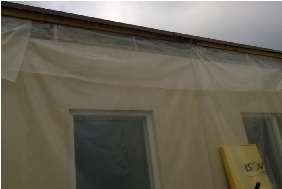
Kuva 3.11. Ulkoseinän kosteussuojaus tutkimuskohteessa.
