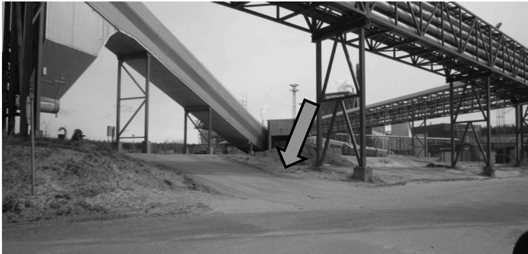
Kuva 5.22. Asfaltointia ja maaperän vahvistamista vaativa nousukohta.
