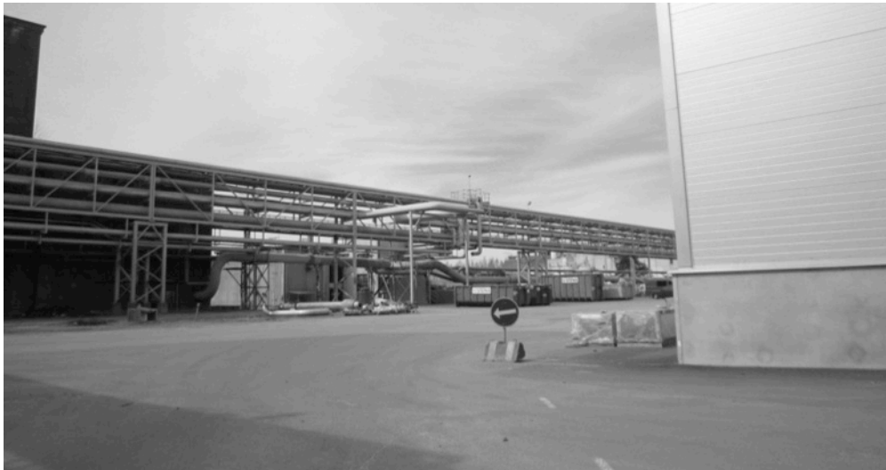
Kuva 5.16. Tielinjauksen päälle rakennettu CP Kelcon uusin tuotantolinja.
