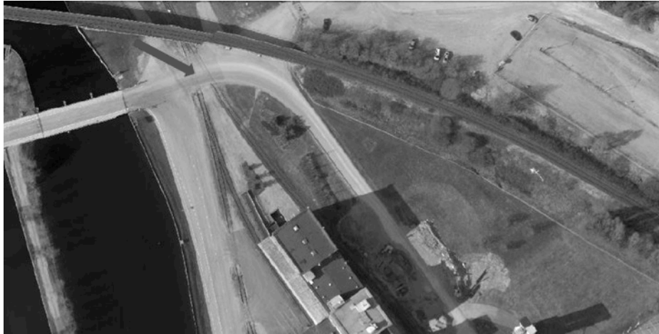
Kuva 5.18. Ilmakuva Hiskinmäen portin viereisestä tasoristeyksestä.
