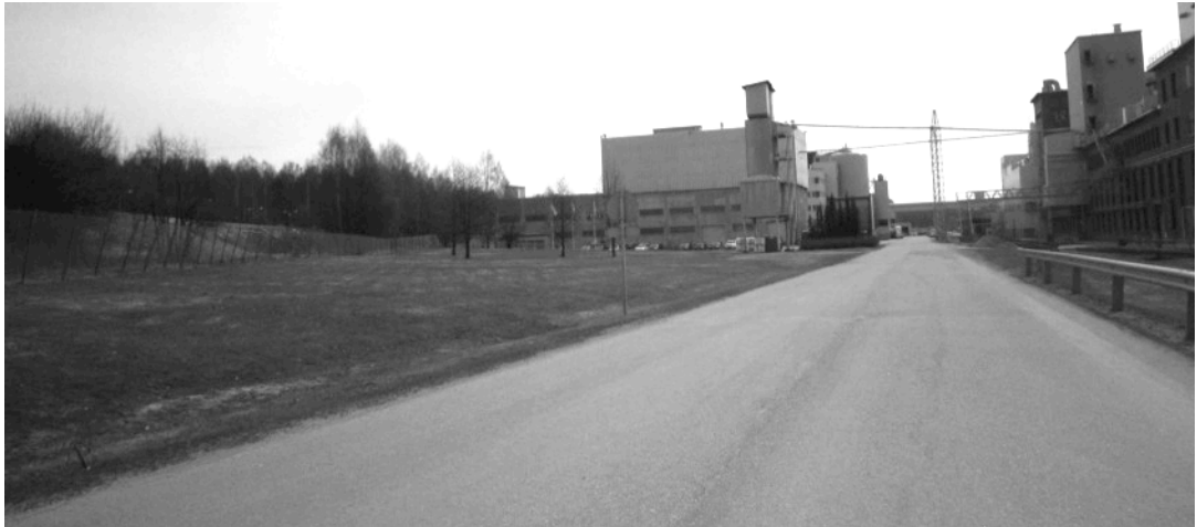
Kuva 5.10. Puuttuva kevyen liikenteen väylä.
